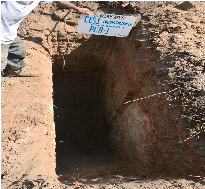
Trabajos de exploración del Pozo a cielo abierto PCA-1.
