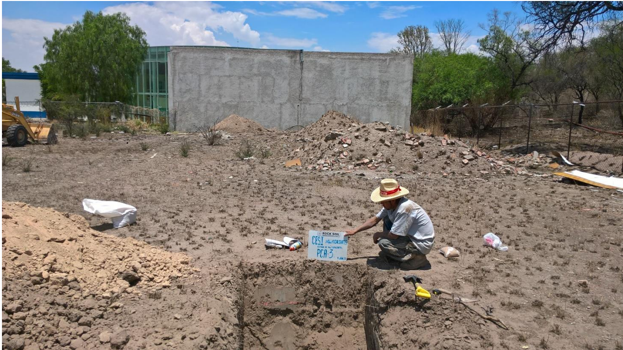
Trabajos de exploración del Pozo a cielo abierto PCA-3.
