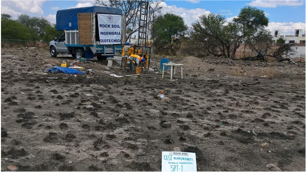
Trabajos de perforación del sondeo SM-1
