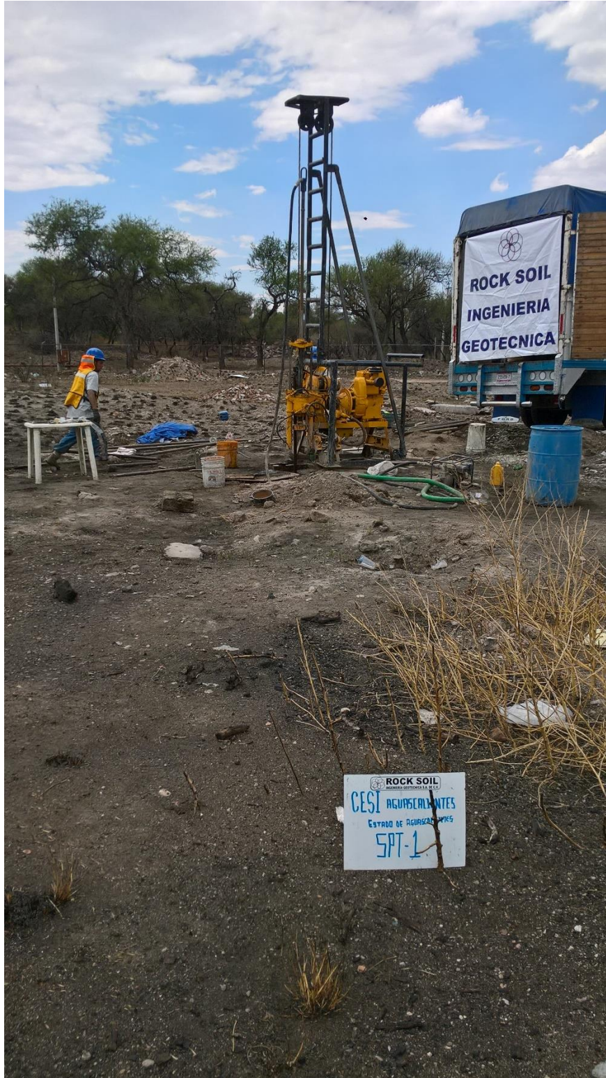
Trabajos de perforación del sondeo SM-1
