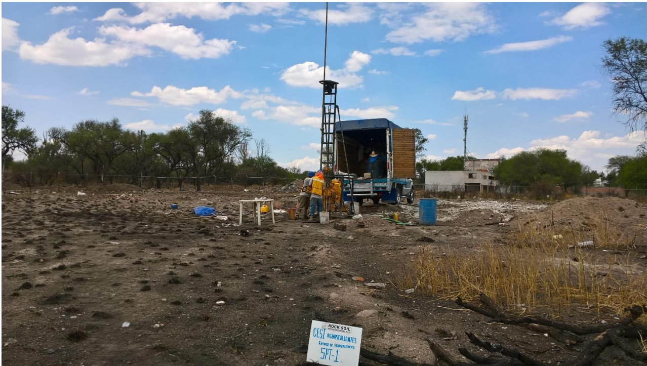
Trabajos de perforación del sondeo SM-1
