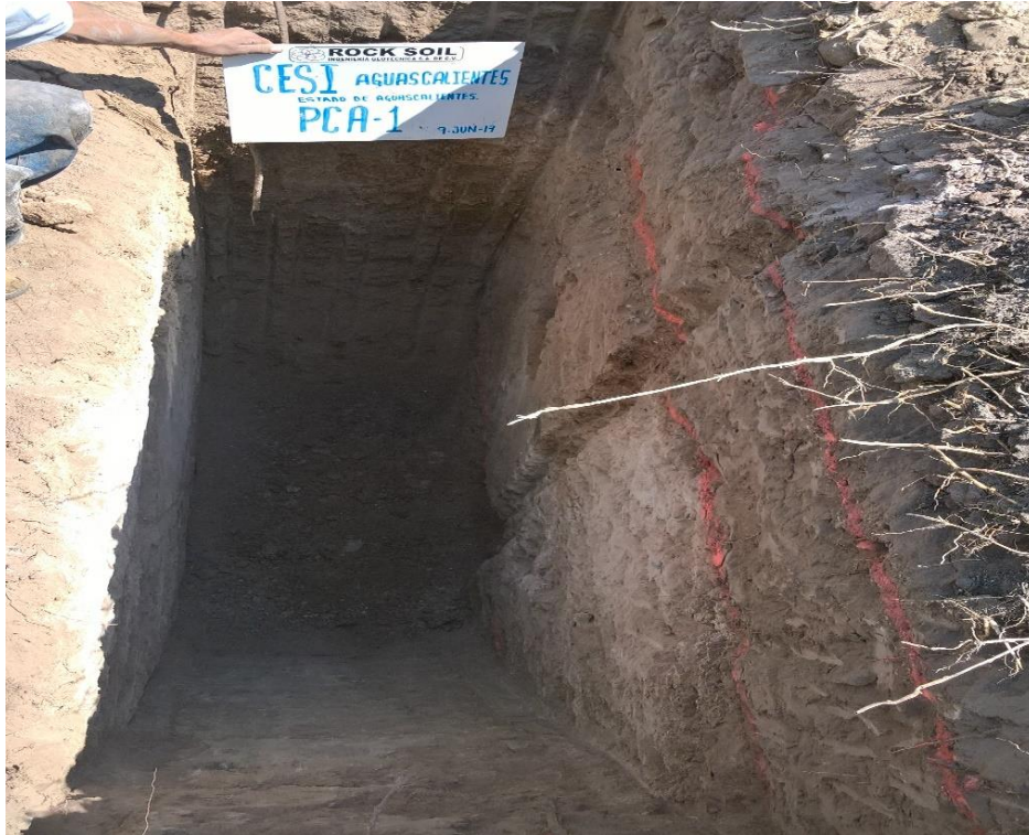
Trabajos de exploración del Pozo a cielo abierto PCA-1.
