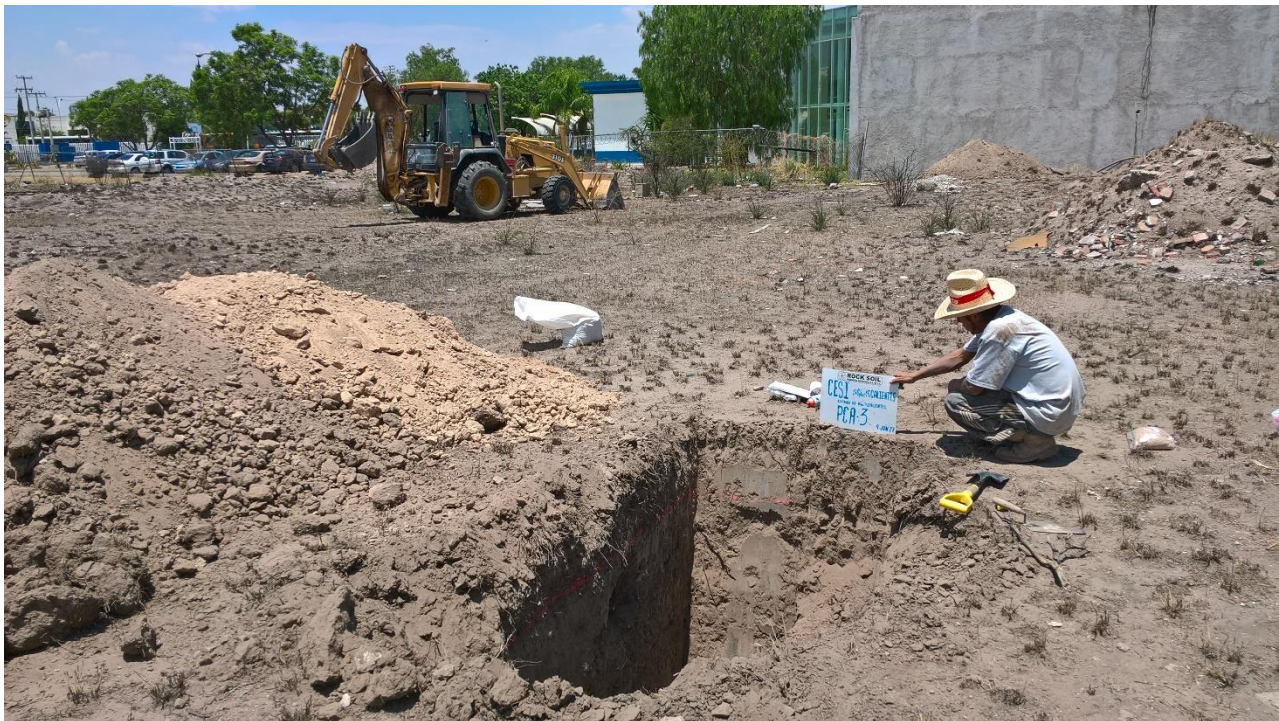
Trabajos de exploración del Pozo a cielo abierto PCA-3.
