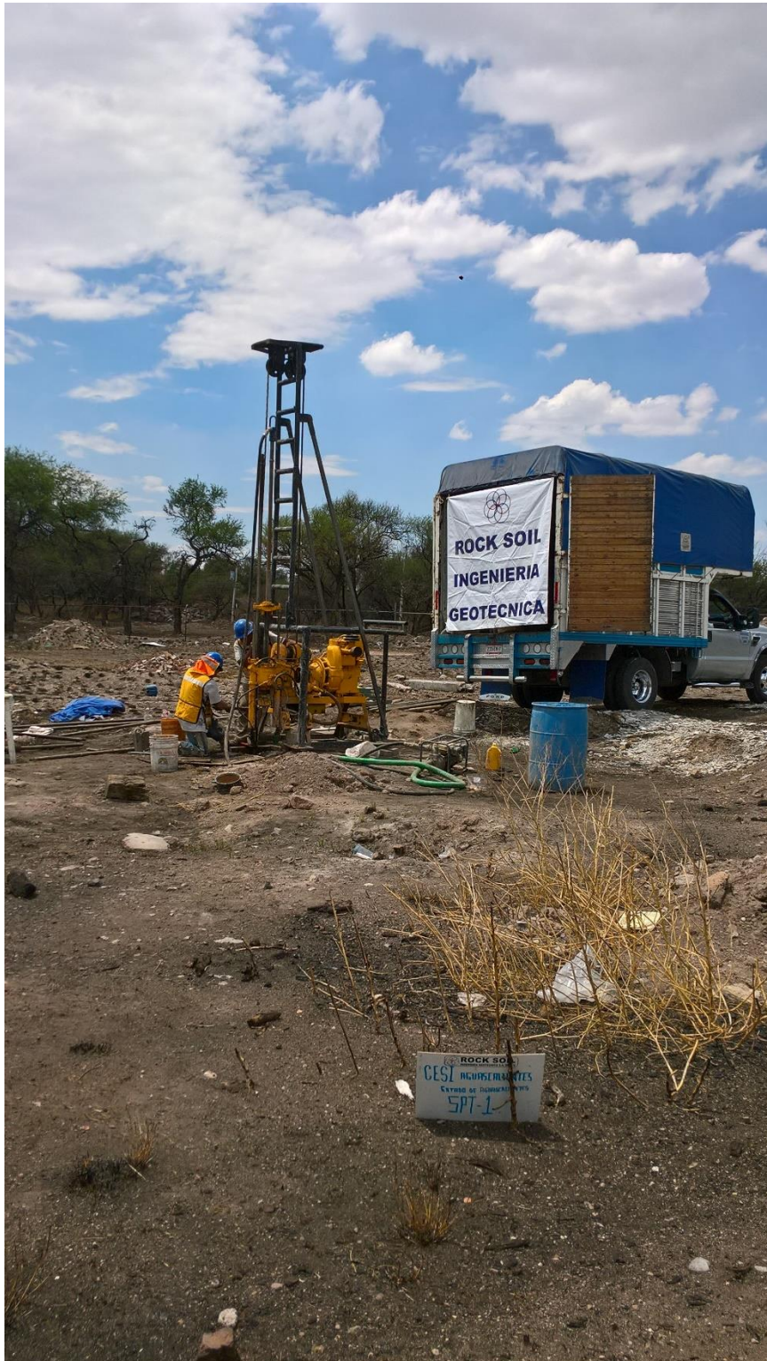
Trabajos de perforación del sondeo SM-1
