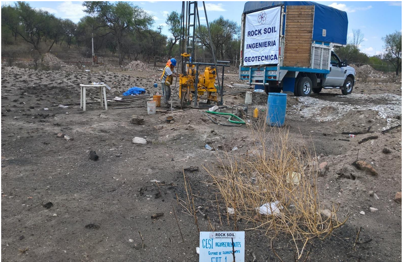
Trabajos de perforación del sondeo SM-1
