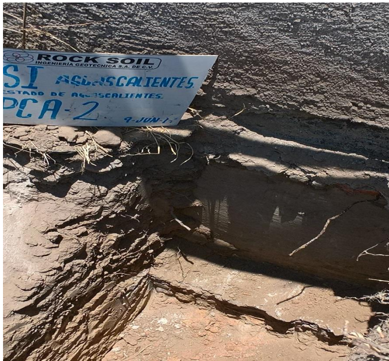
Trabajos de exploración del Pozo a cielo abierto PCA-2.
