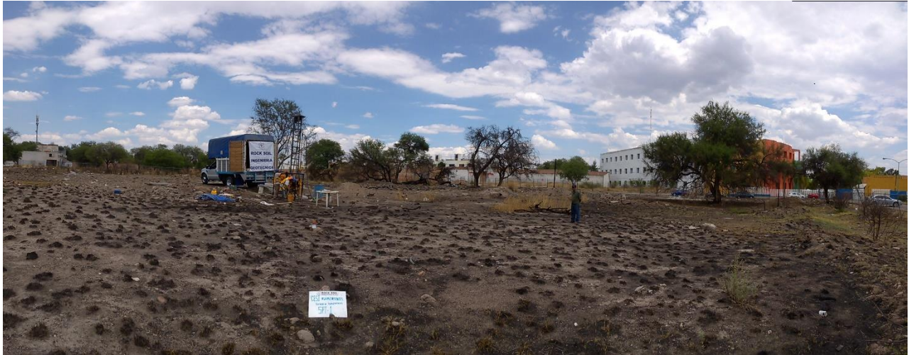
Trabajos de perforación del sondeo SM-1
