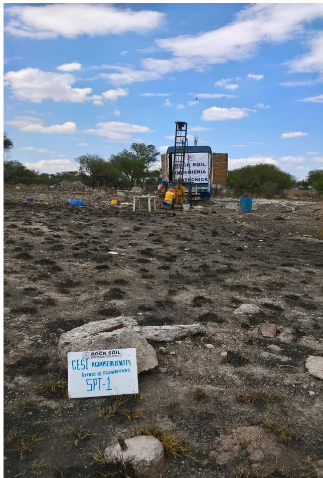
Trabajos de perforación del sondeo SM-1
