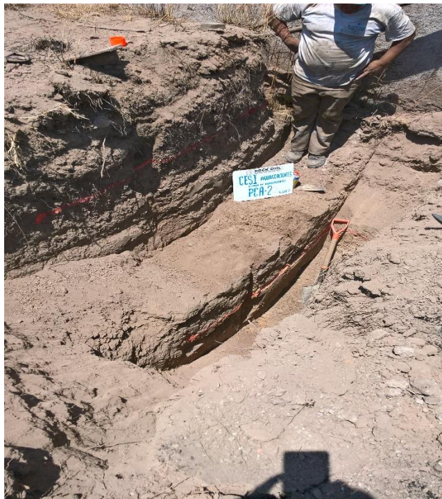
Trabajos de exploración del Pozo a cielo abierto PCA-2.
