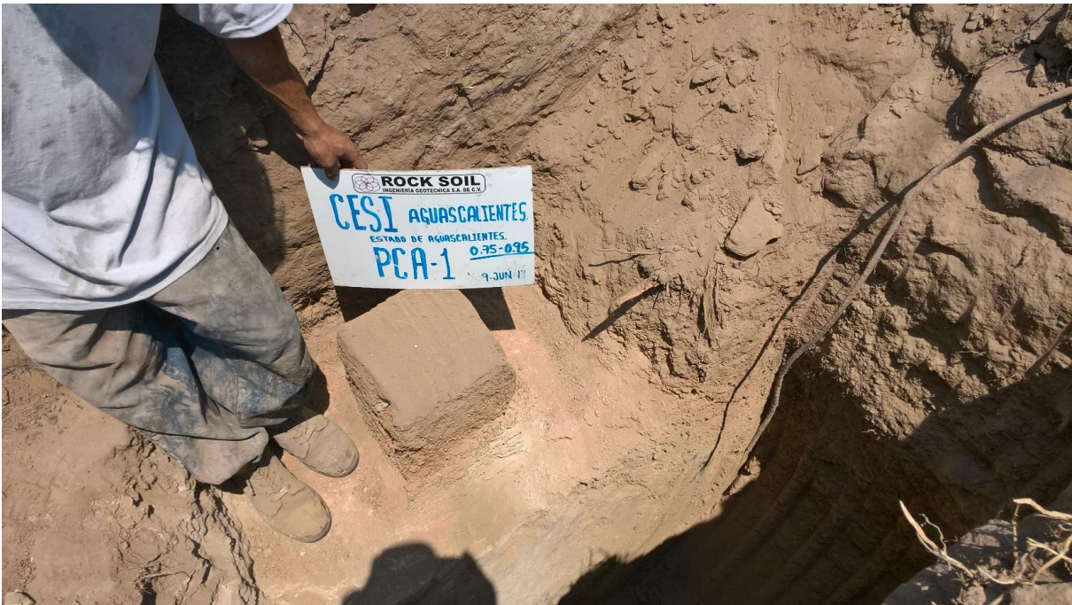
Trabajos de exploración del Pozo a cielo abierto PCA-1.
