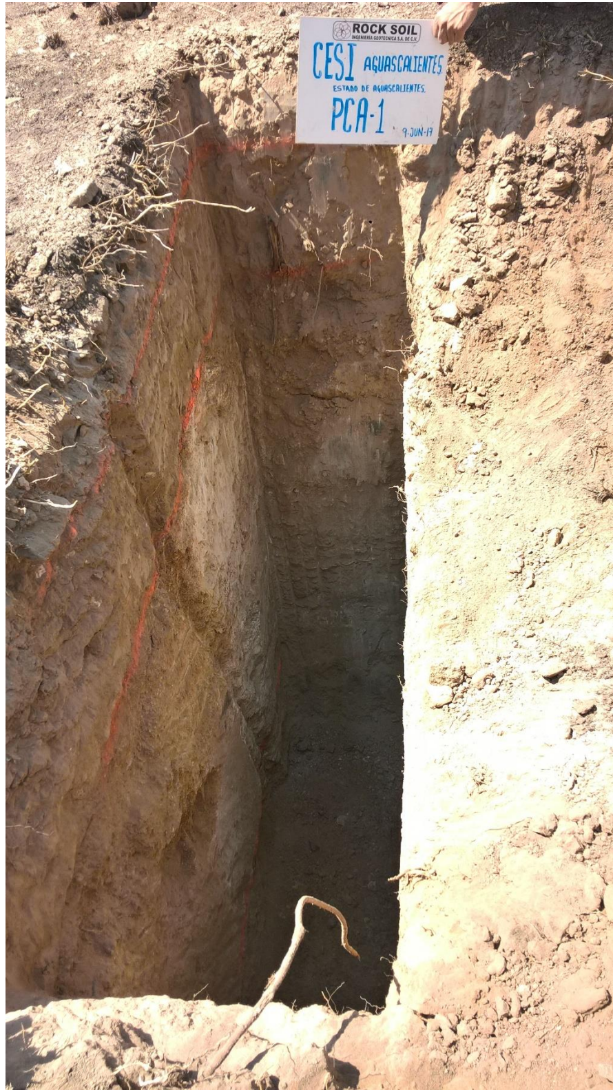
Trabajos de exploración del Pozo a cielo abierto PCA-1.
