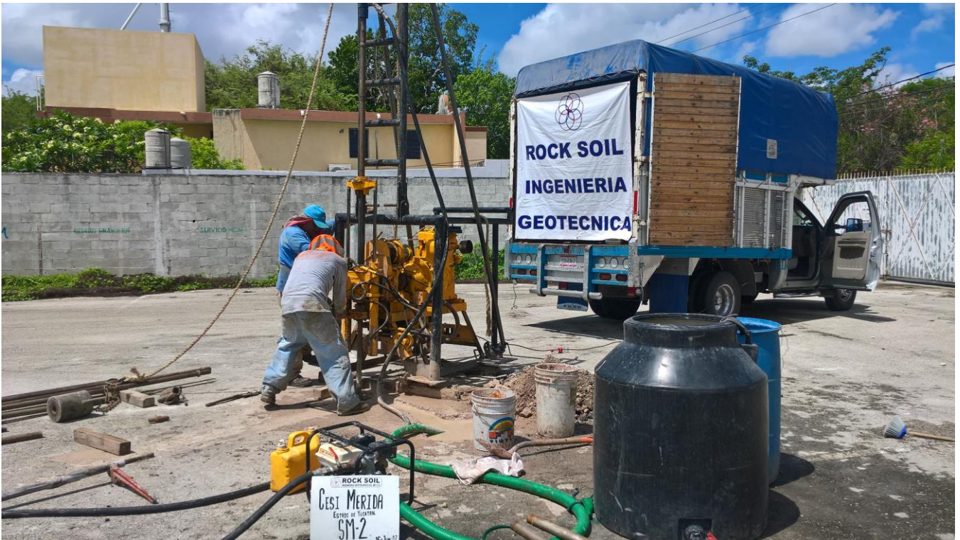
Trabajos de perforación del sondeo SM-2
