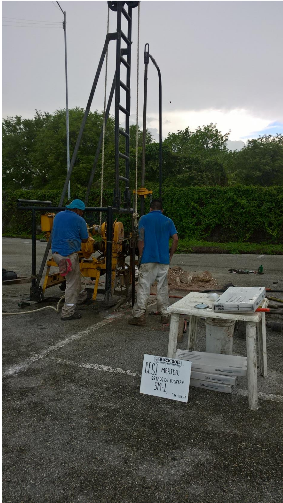
Trabajos de perforación del sondeo SM-1
