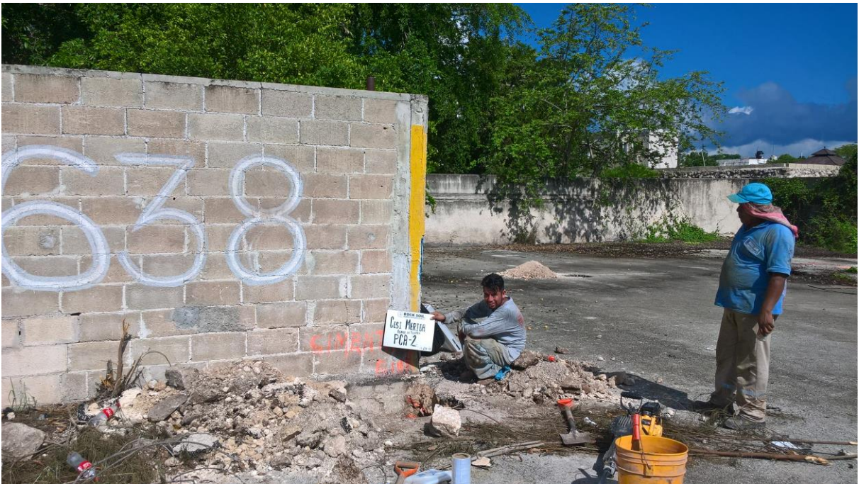
Trabajos de exploración del Pozo a cielo abierto PCA-2.
