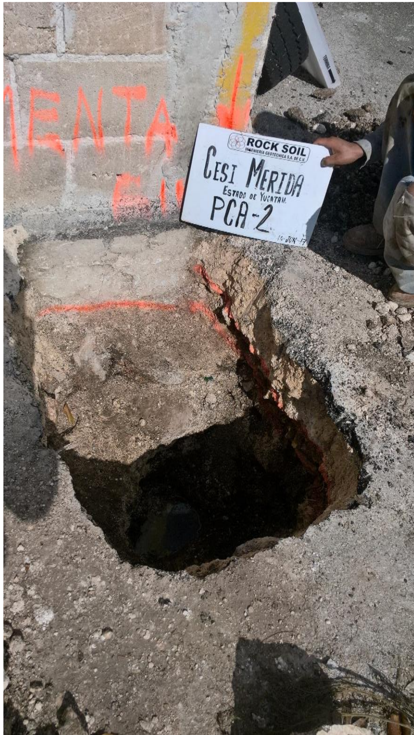
Trabajos de exploración del Pozo a cielo abierto PCA-2.
