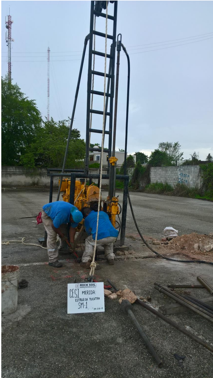
Trabajos de perforación del sondeo SM-1
