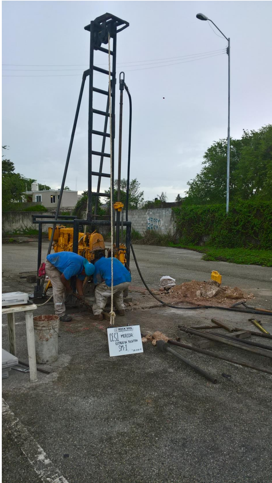
Trabajos de perforación del sondeo SM-1
