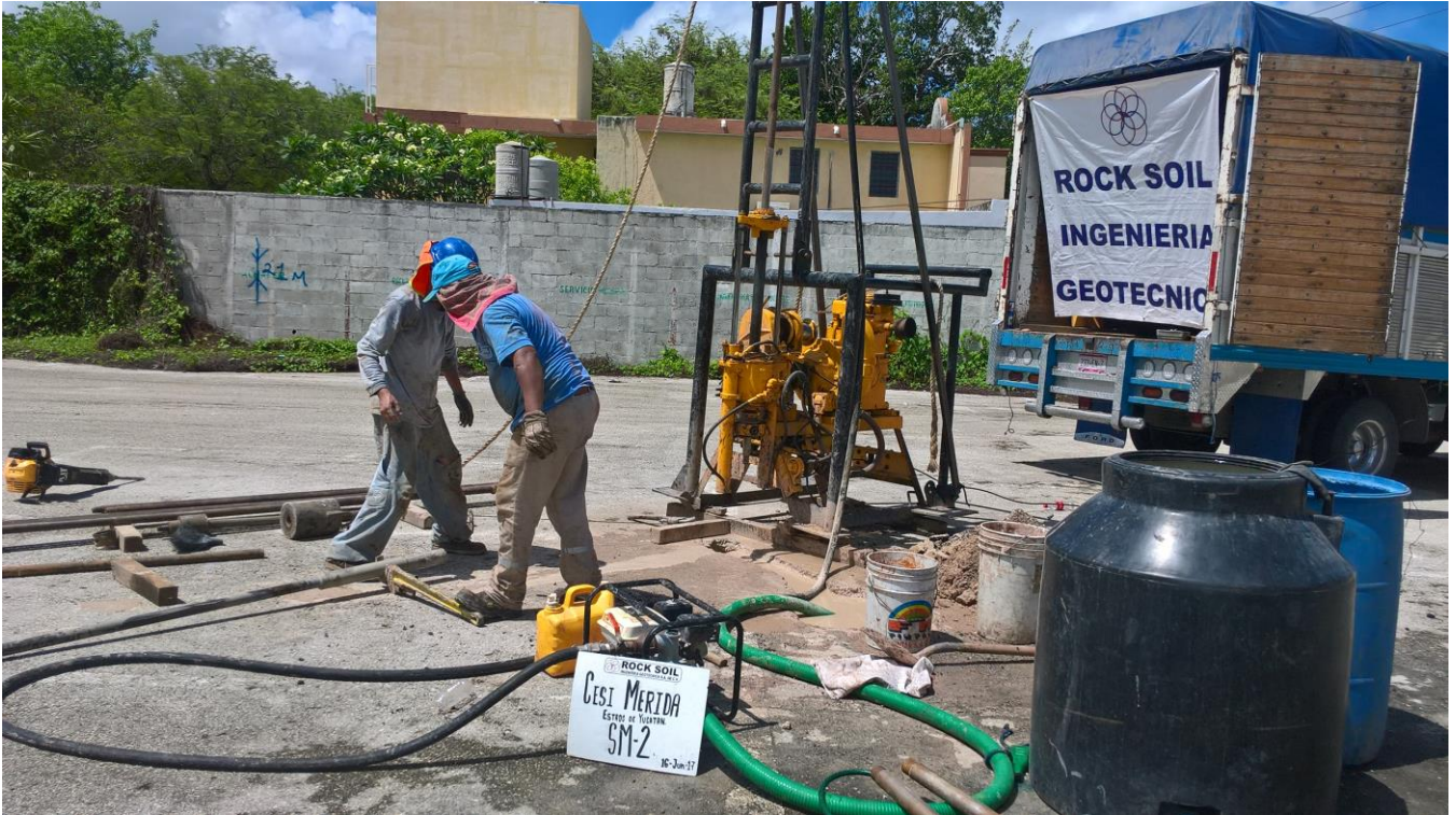
Trabajos de perforación del sondeo SM-2
