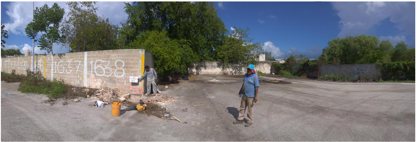
Trabajos de exploración del Pozo a cielo abierto PCA-2.
