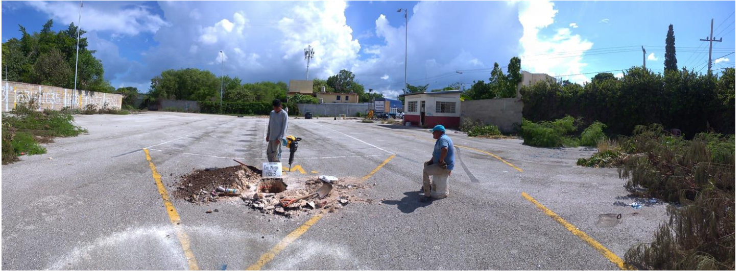
Trabajos de exploración del Pozo a cielo abierto PCA-3.
