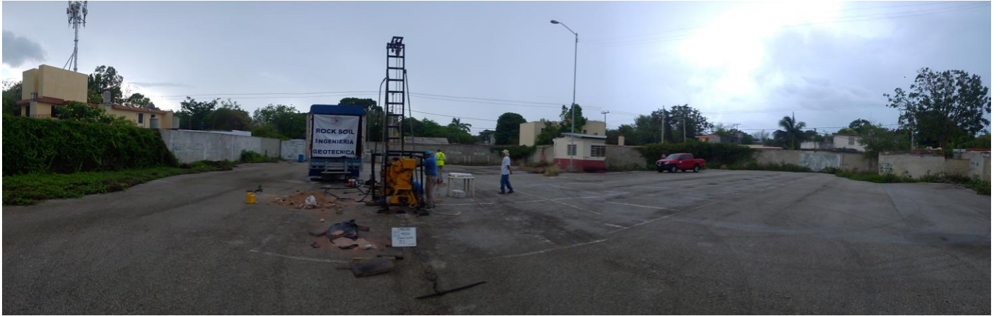
Trabajos de perforación del sondeo SM-1
