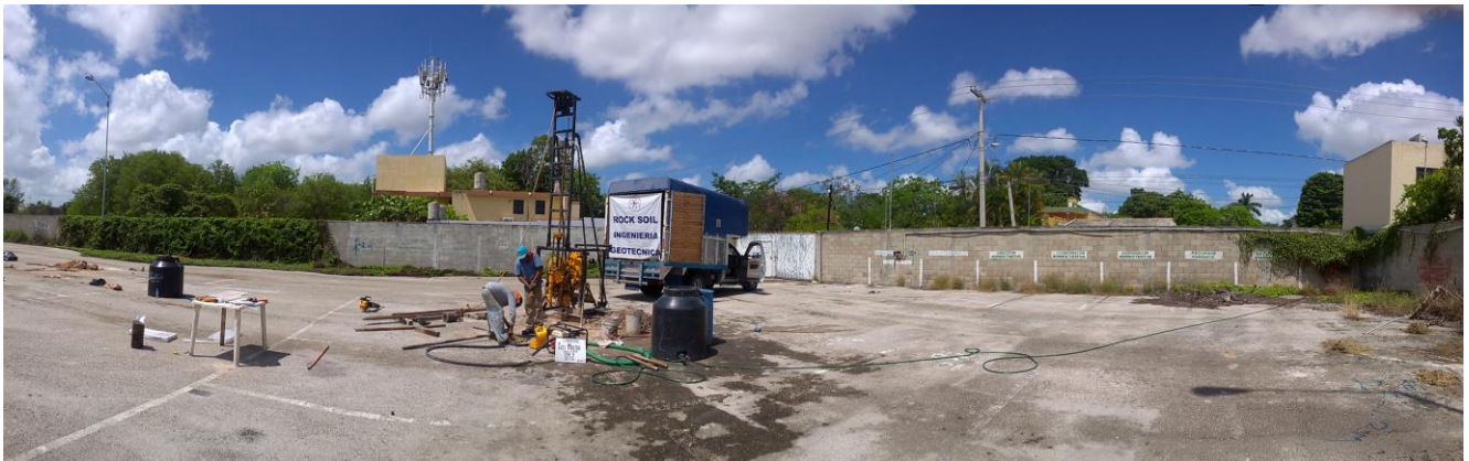
Trabajos de perforación del sondeo SM-2
