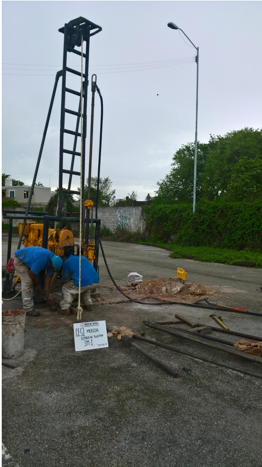
Trabajos de perforación del sondeo SM-1
