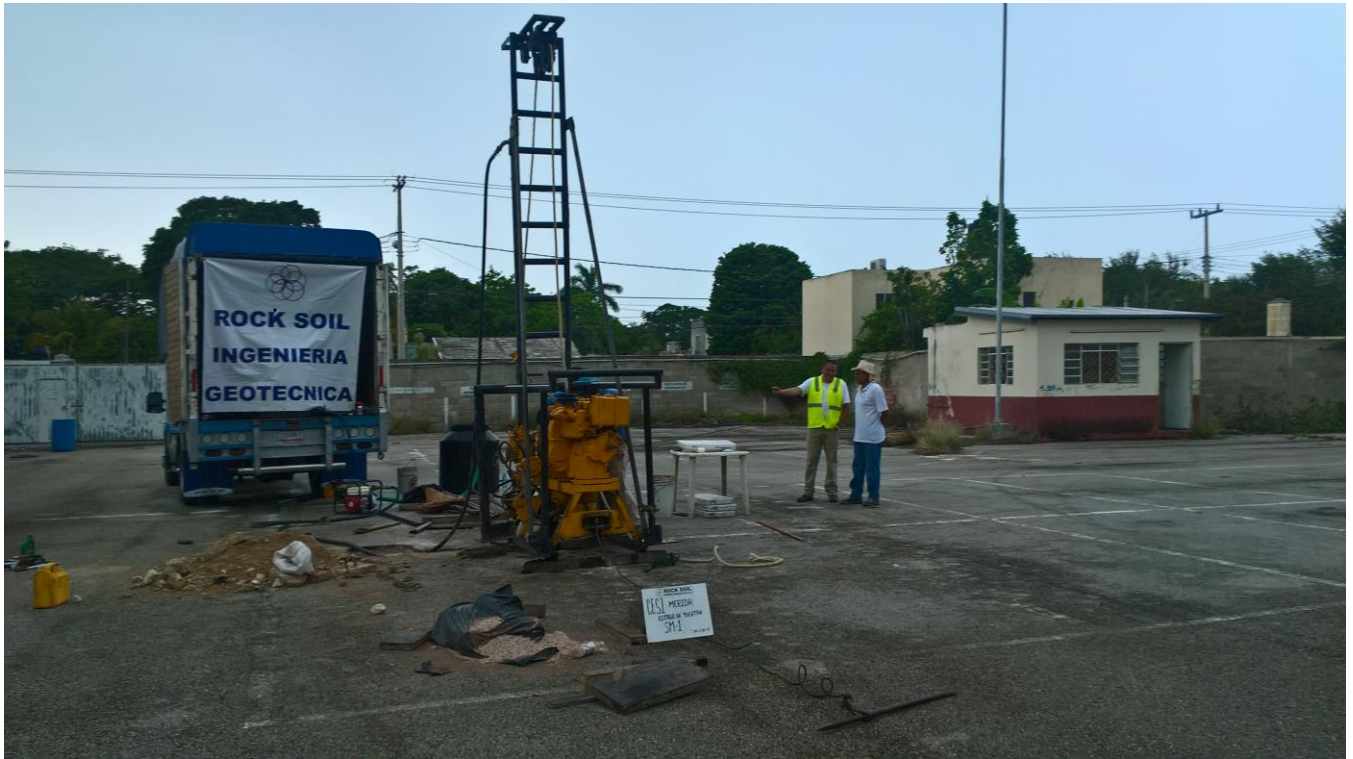
Trabajos de perforación del sondeo SM-1
