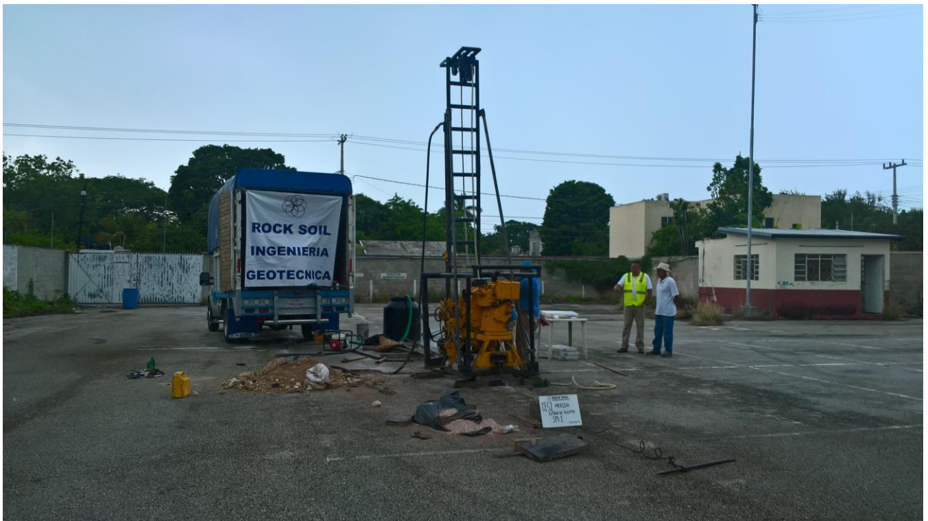
Trabajos de perforación del sondeo SM-1
