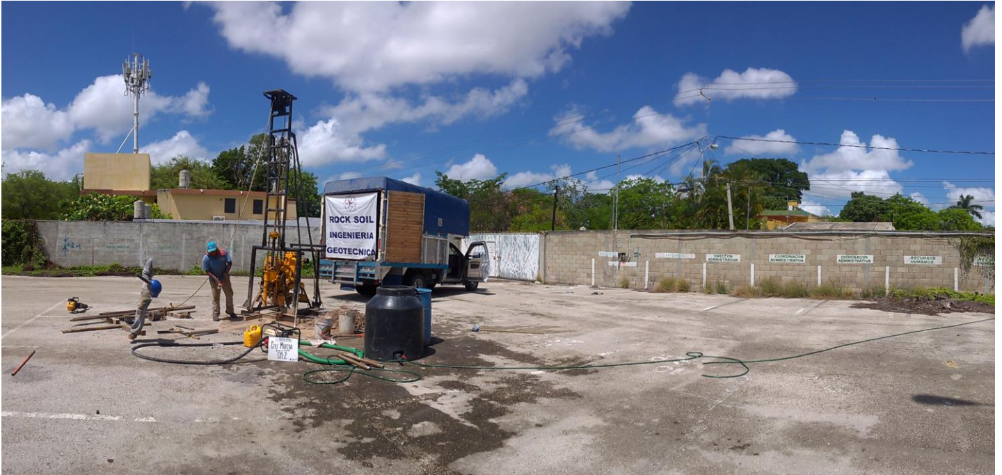
Trabajos de perforación del sondeo SM-2
