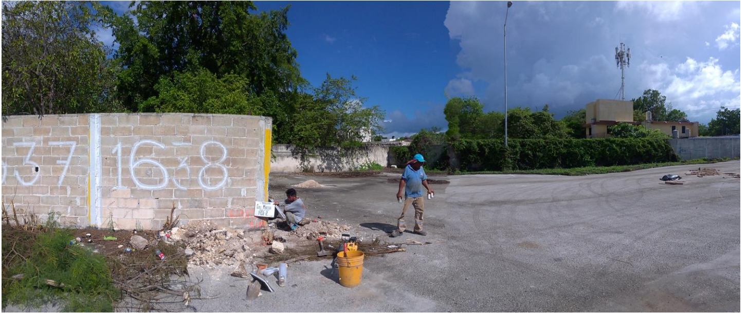
Trabajos de exploración del Pozo a cielo abierto PCA-2.
