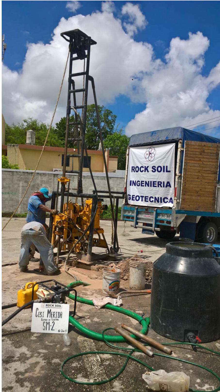
Trabajos de perforación del sondeo SM-2
