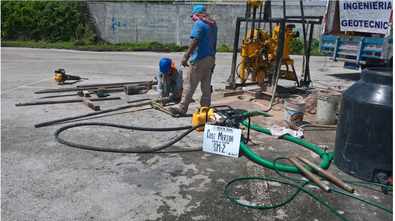
Trabajos de perforación del sondeo SM-2
