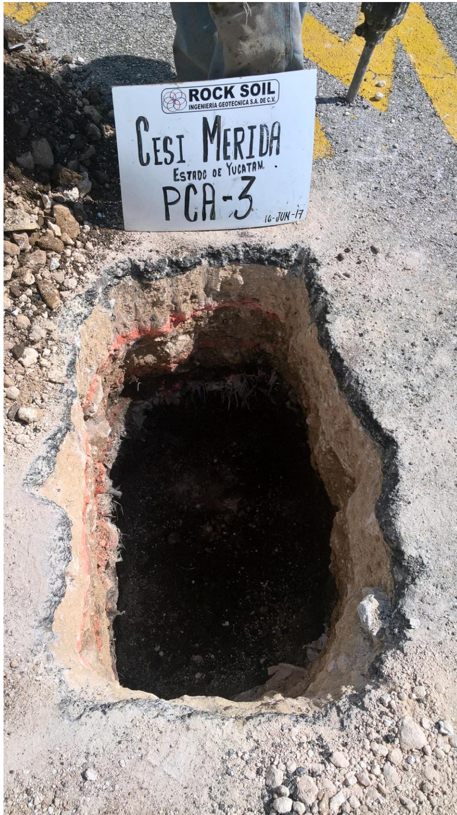
Trabajos de exploración del Pozo a cielo abierto PCA-3.
