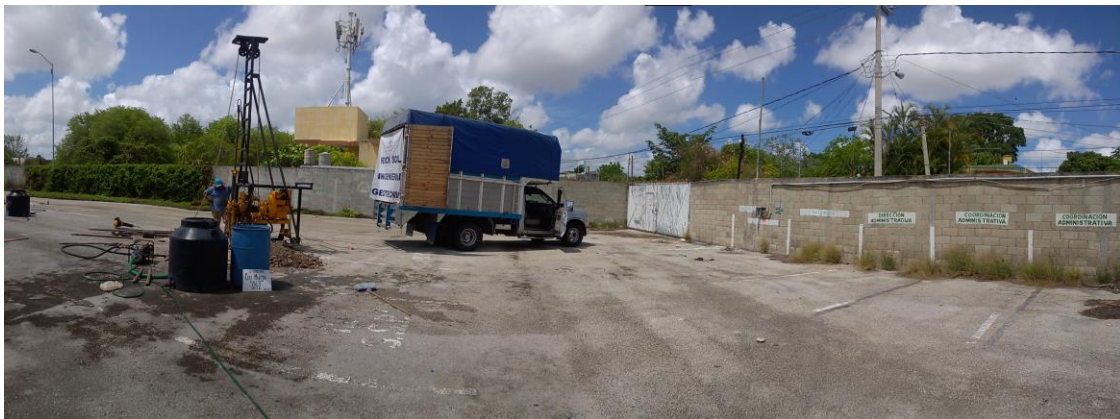
Trabajos de perforación del sondeo SM-2
