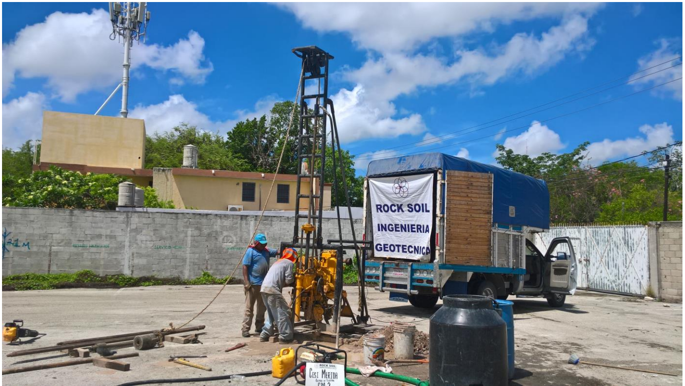
Trabajos de perforación del sondeo SM-2
