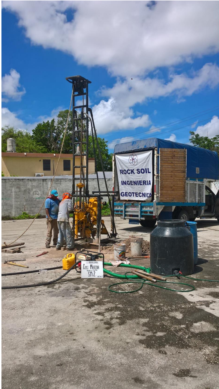
Trabajos de perforación del sondeo SM-2
