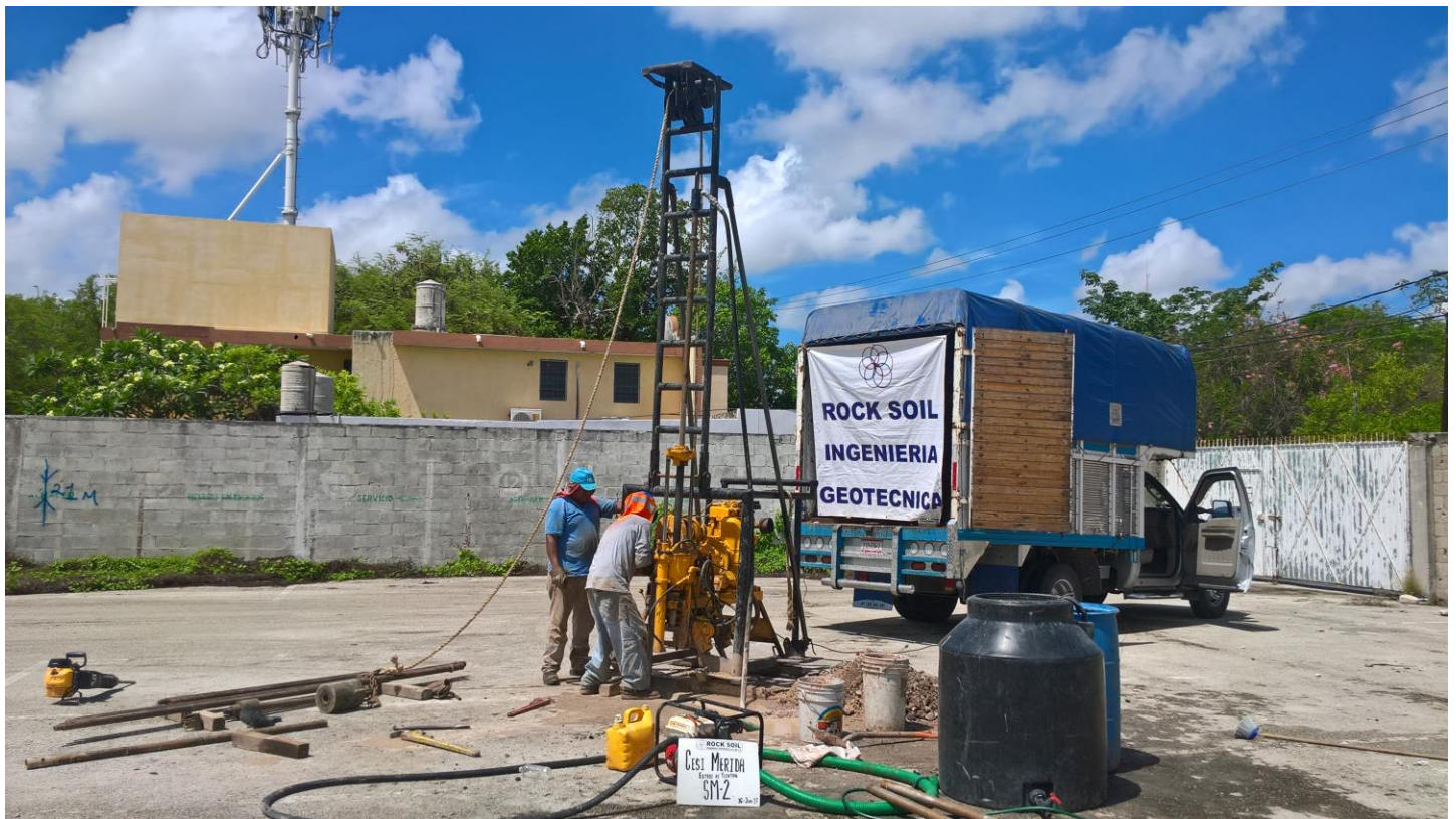
Trabajos de perforación del sondeo SM-2
