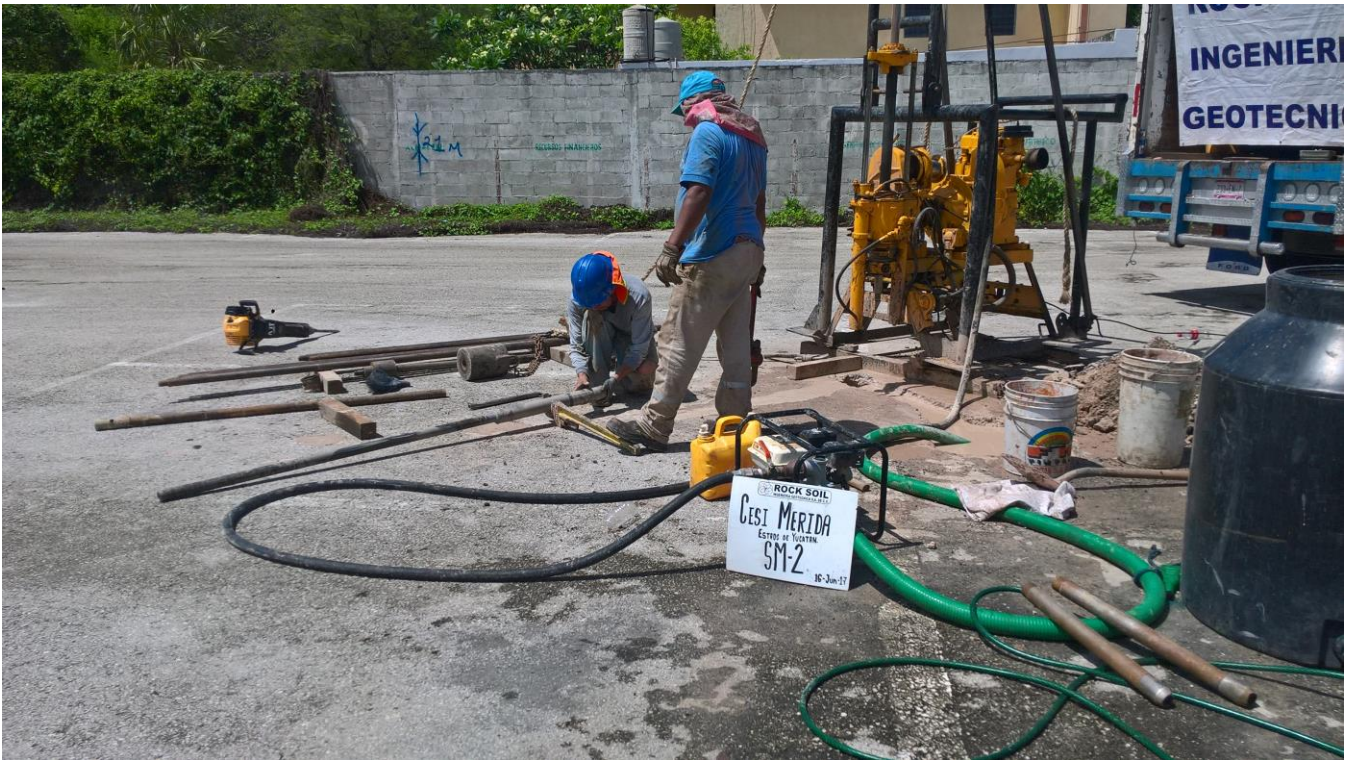
Trabajos de perforación del sondeo SM-2
