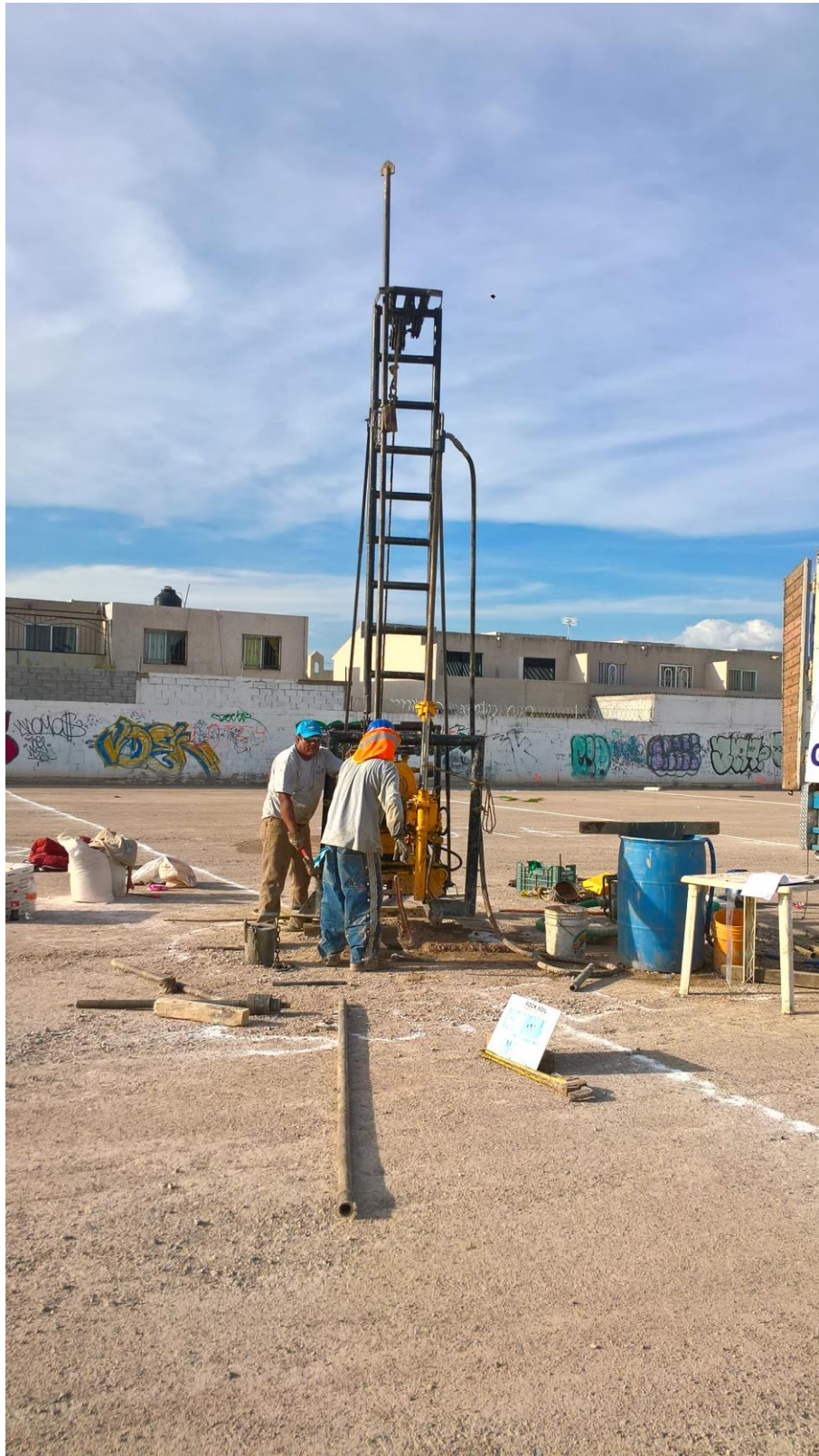
Trabajos de perforación del sondeo SM-1
