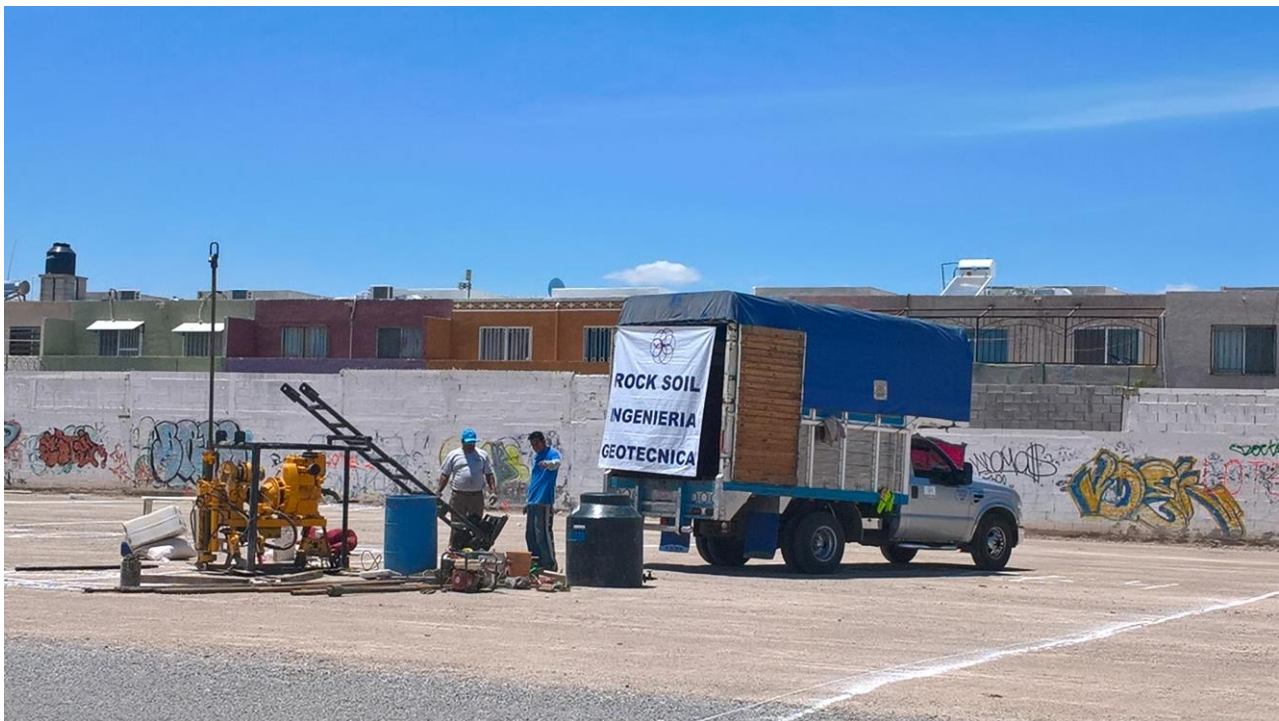
Trabajos de perforación del sondeo SM-1
