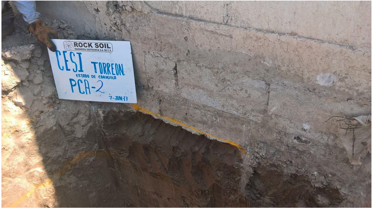
Trabajos de exploración del Pozo a cielo abierto PCA-2.
