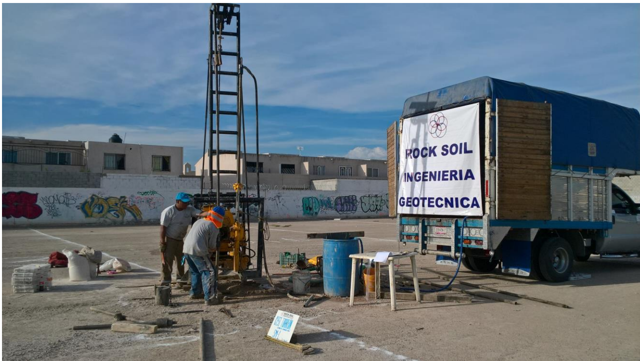
Trabajos de perforación del sondeo SM-1
