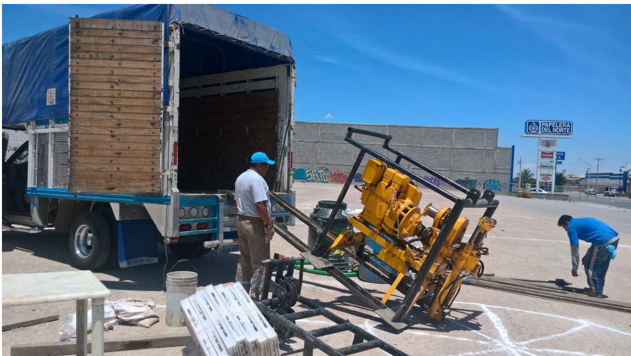
Trabajos de perforación del sondeo SM-1
