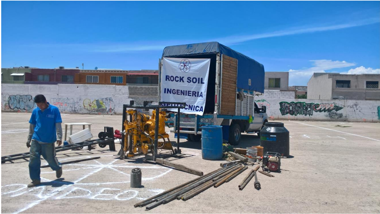
Trabajos de perforación del sondeo SM-1
