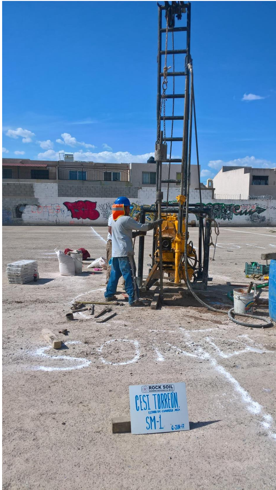
Trabajos de perforación del sondeo SM-1
