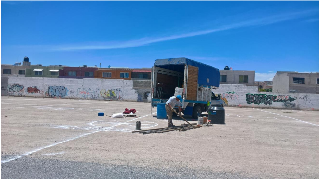
Trabajos de perforación del sondeo SM-1
