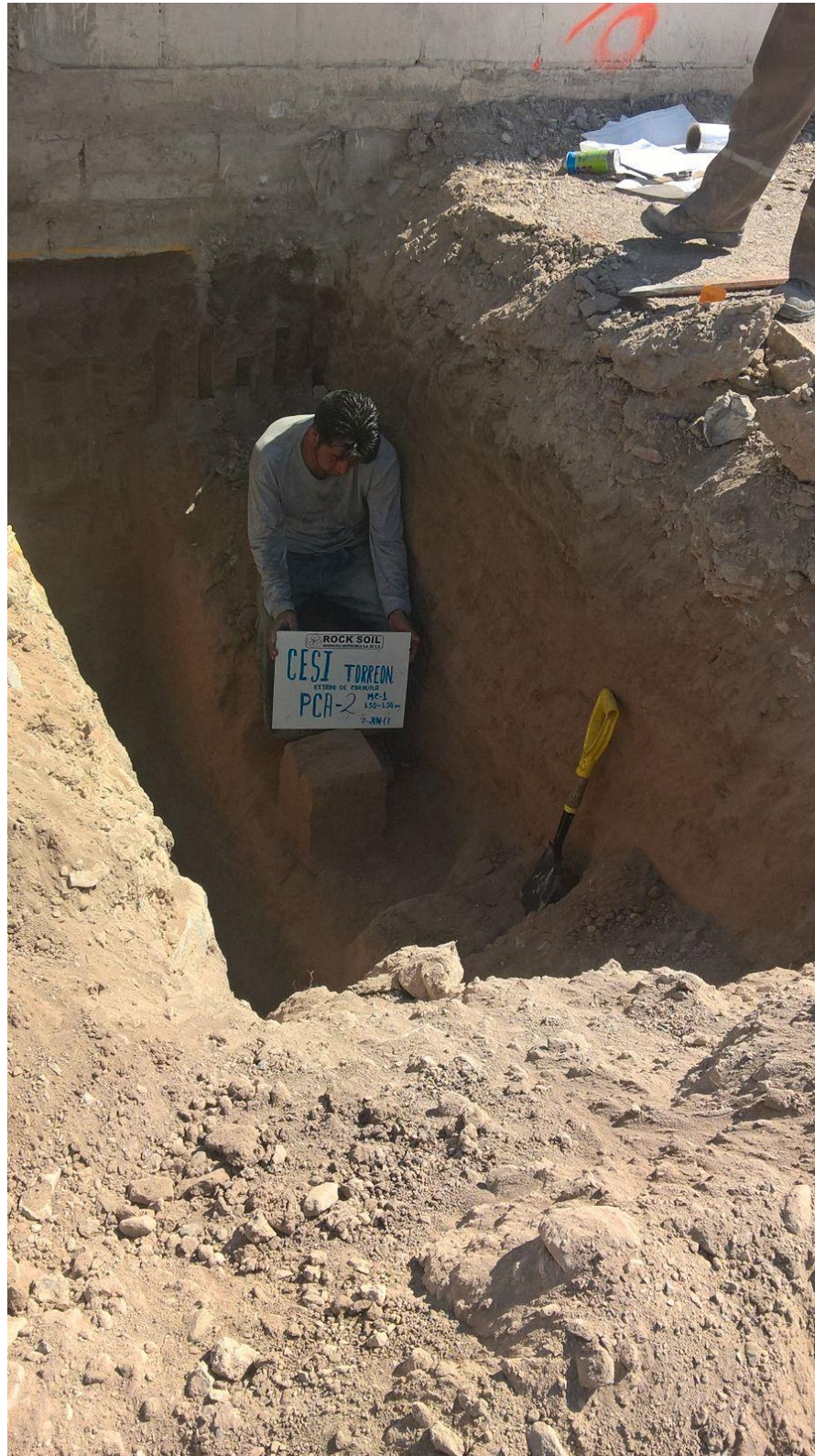
Trabajos de exploración del Pozo a cielo abierto PCA-2.
