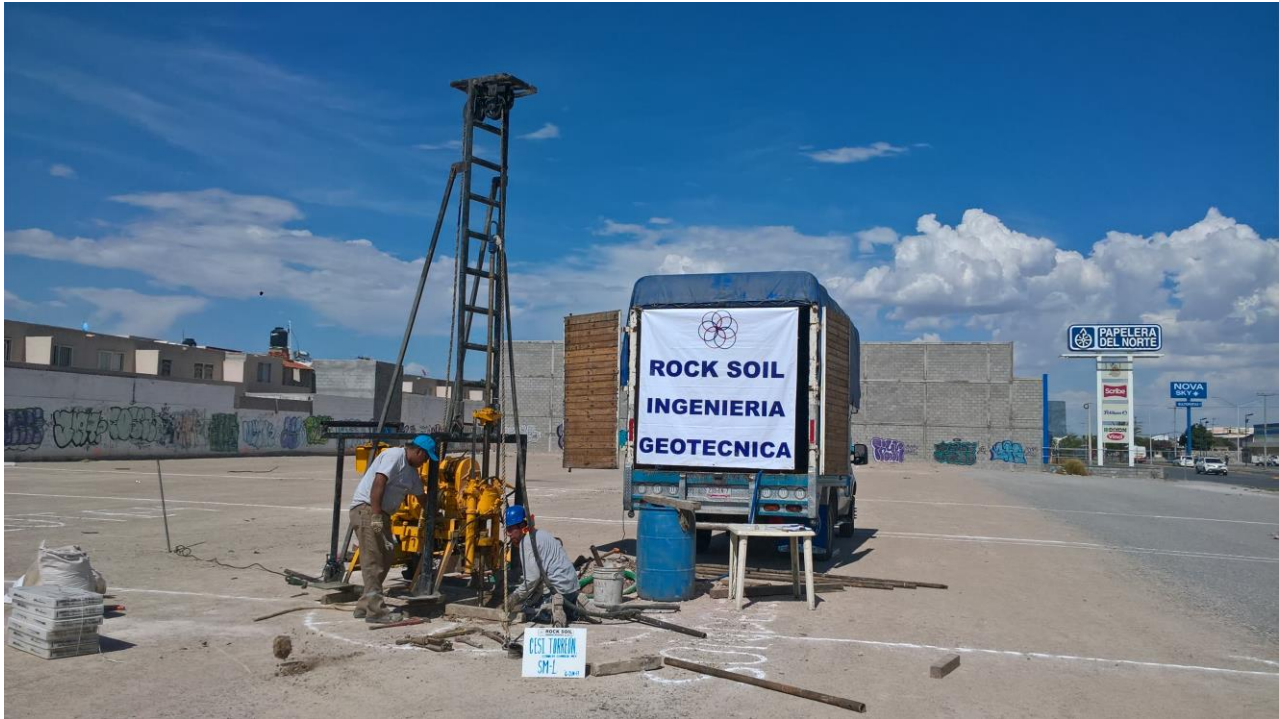
Trabajos de perforación del sondeo SM-1
