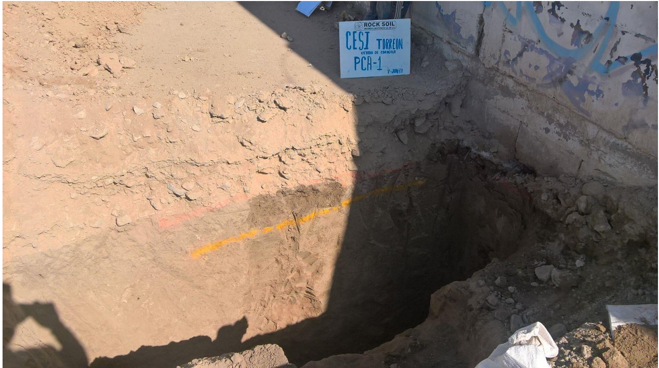
Trabajos de exploración del Pozo a cielo abierto PCA-1.
