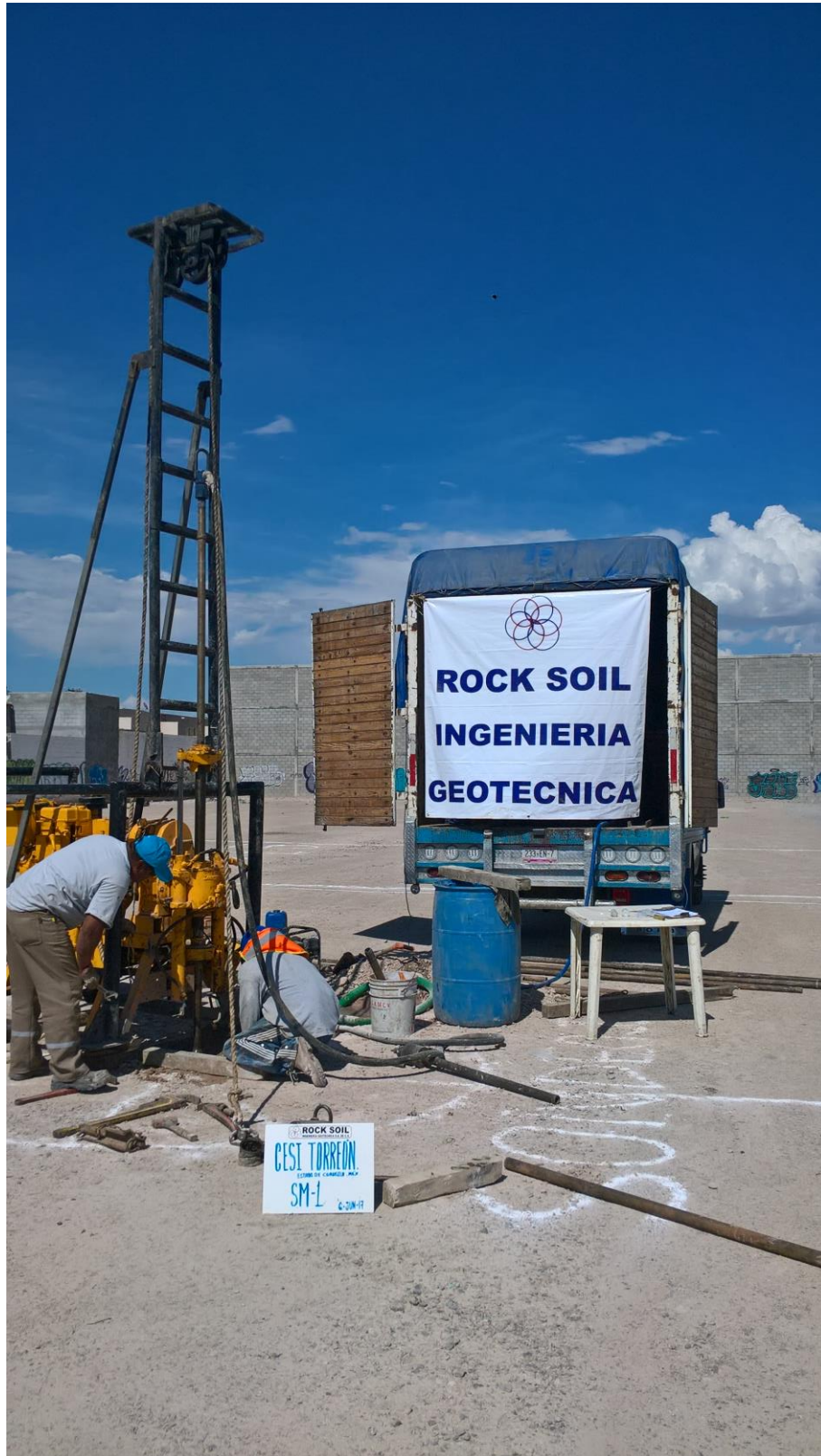
Trabajos de perforación del sondeo SM-1
