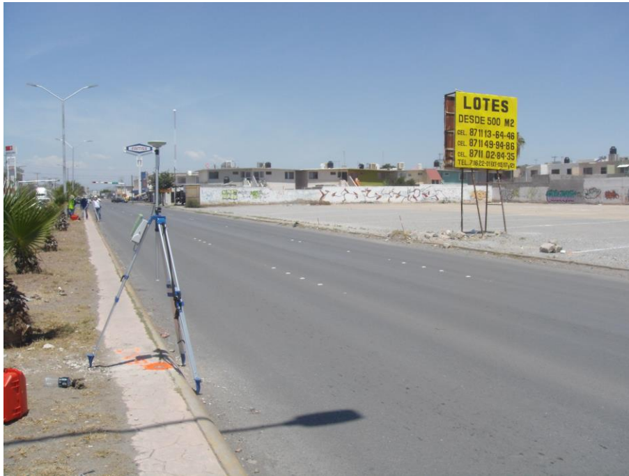
Trabajos de topografía para el Centro de Servicio Infonavit (CESI) Torreón, Coahuila.
