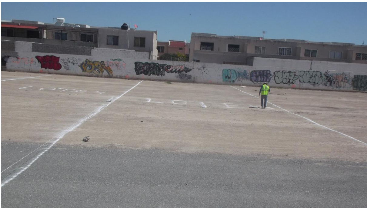
Trabajos de topografía para el Centro de Servicio Infonavit (CESI) Torreón, Coahuila.
