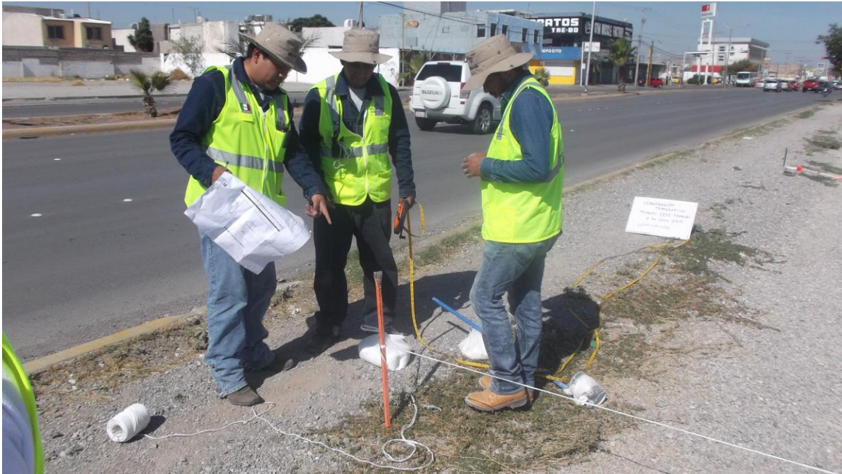
Trabajos de topografía para el Centro de Servicio Infonavit (CESI) Torreón, Coahuila.
