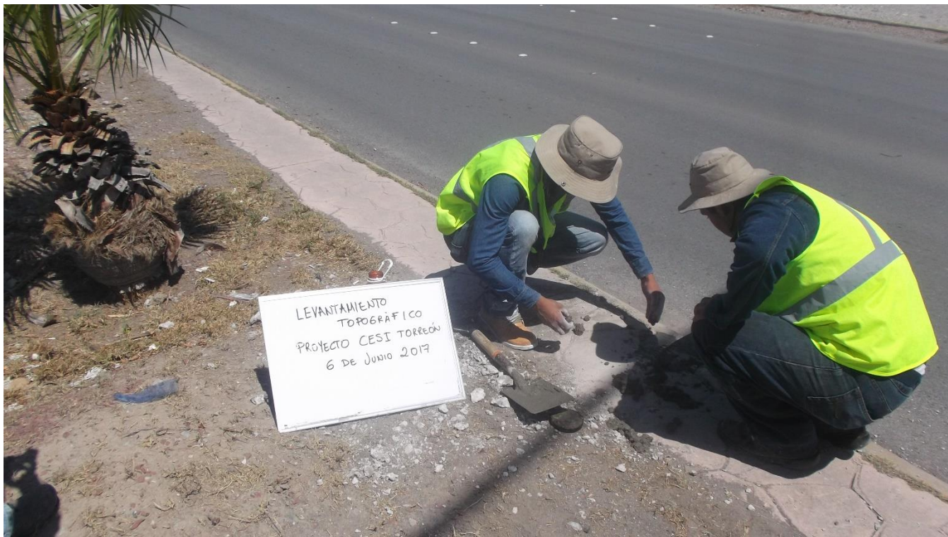
Trabajos de topografía para el proyecto "CESI" SEDE TORREÓN.
