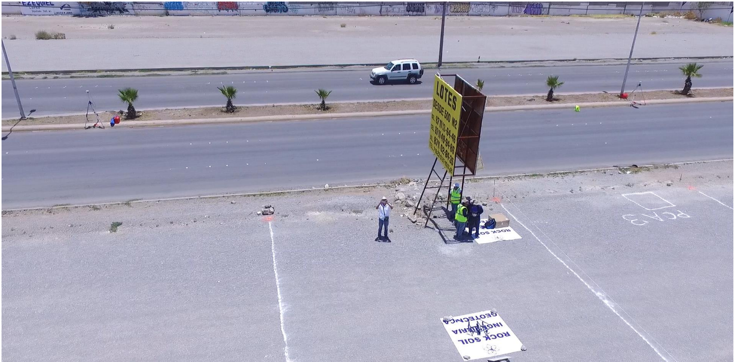
Trabajos de topografía para el proyecto “CESI” SEDE TORREÓN.
