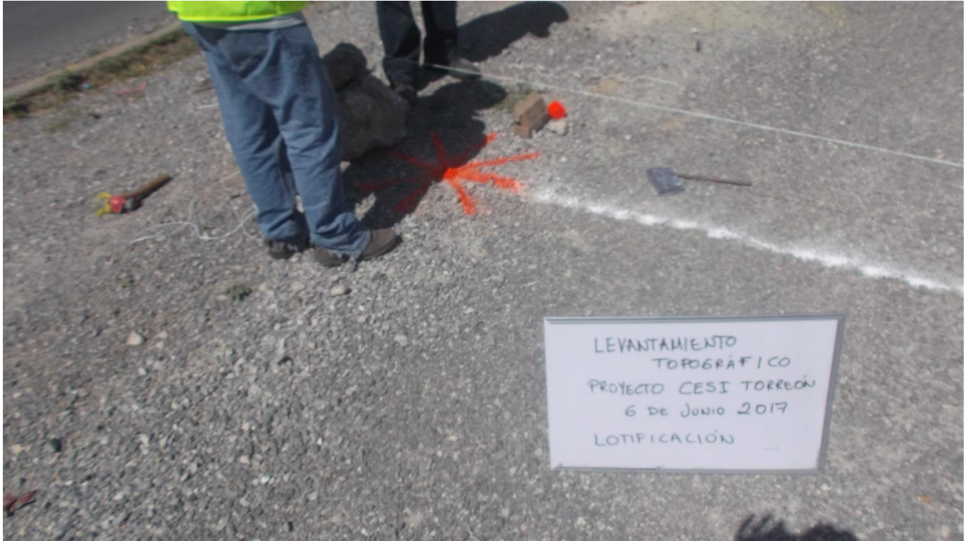
Trabajos de topografía para el proyecto "CESI" SEDE TORREÓN.
