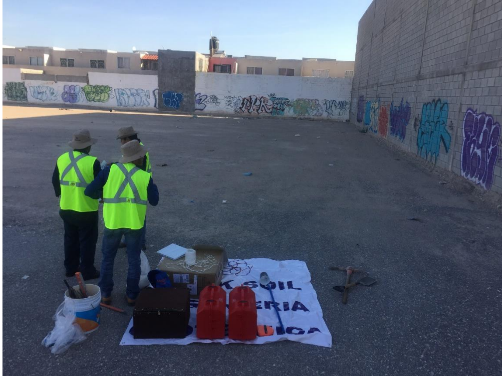
Trabajos de topografía para el proyecto "CESI" SEDE TORREÓN.
