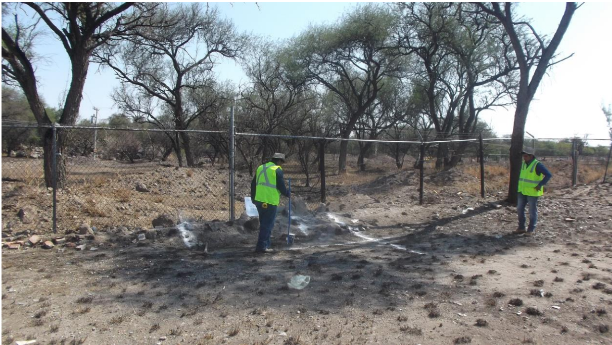
Trabajos de topografía para el Centro de Servicio Infonavit (CESI) Aguascalientes, Aguascalientes.
