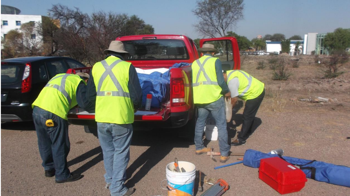
Trabajos de topografía para el Centro de Servicio Infonavit (CESI) Aguascalientes, Aguascalientes.
