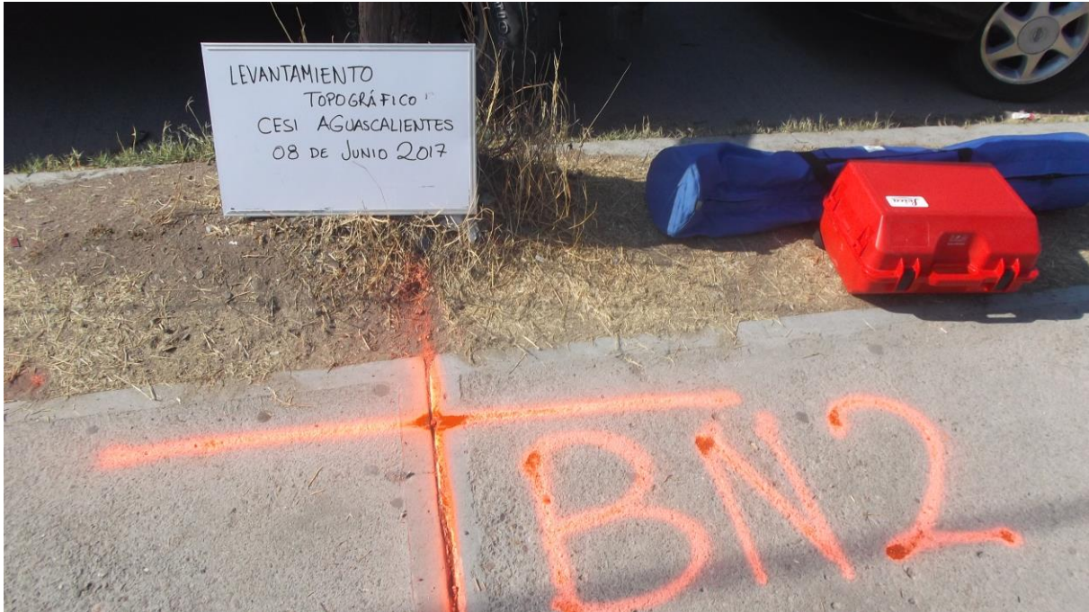
Trabajos de topografía para el Centro de Servicio Infonavit (CESI) Aguascalientes, Aguascalientes.
