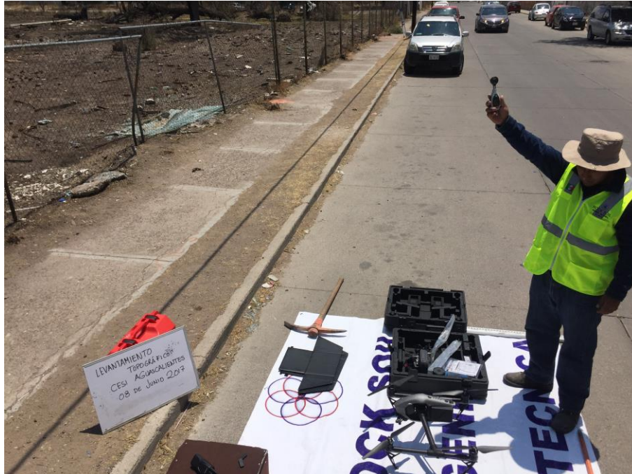
Trabajos de topografía para el Centro de Servicio Infonavit (CESI) Aguascalientes, Aguascalientes.
