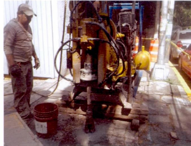
Foto 5 y 6. Maniobras de entrada e inicio de la perforación para INC-3 ✓
