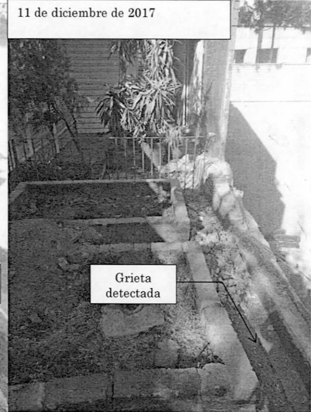
Foto 3. Comparativa de la fisura detectada en la orilla de la colindancia el 13 de noviembre y el 11 de diciembre de 2017
