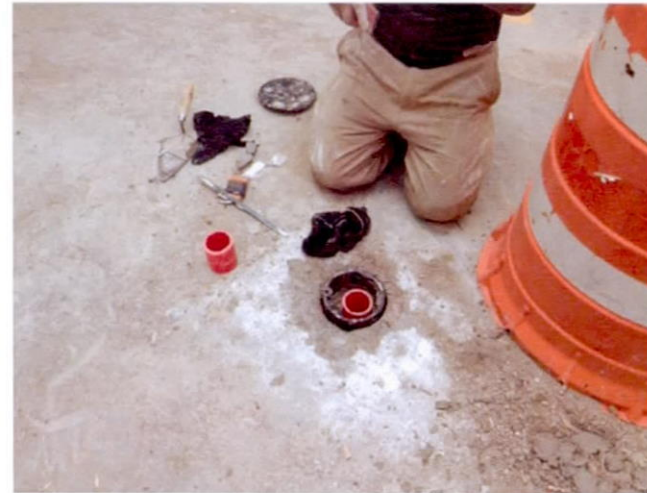
Instalación de INC-2
