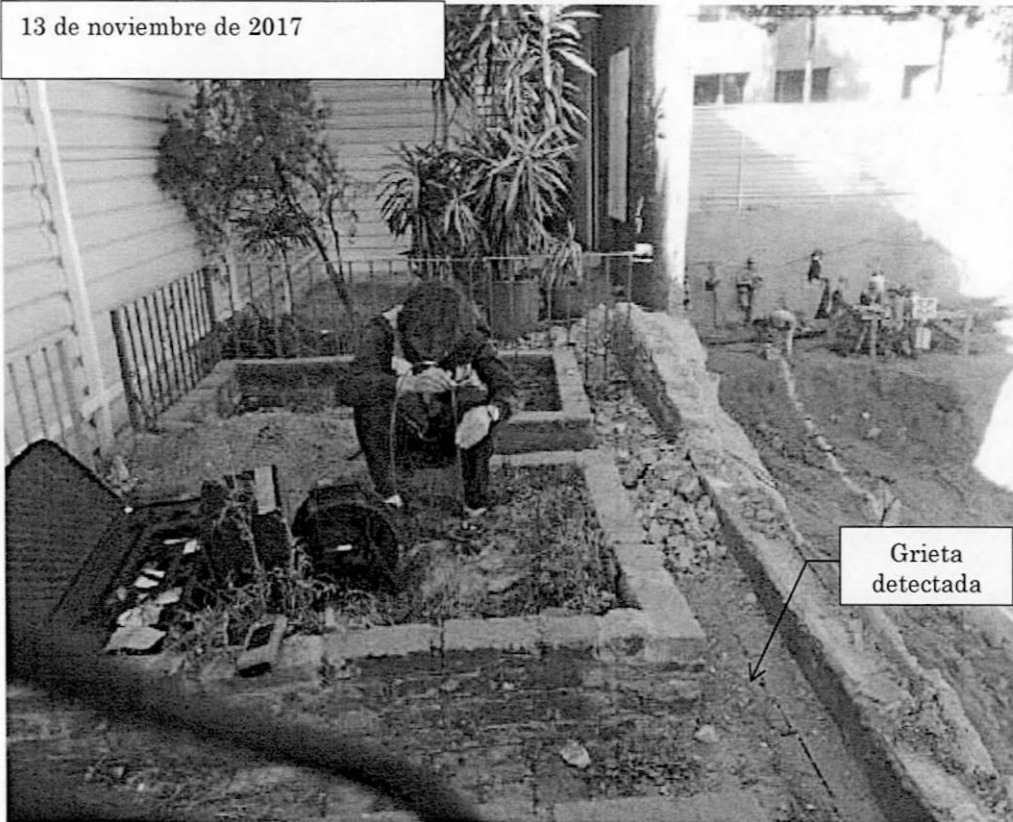
Foto 3. Comparativa de la fisura detectada en la orilla de la colindancia el 13 de noviembre y el 11 de diciembre de 2017
