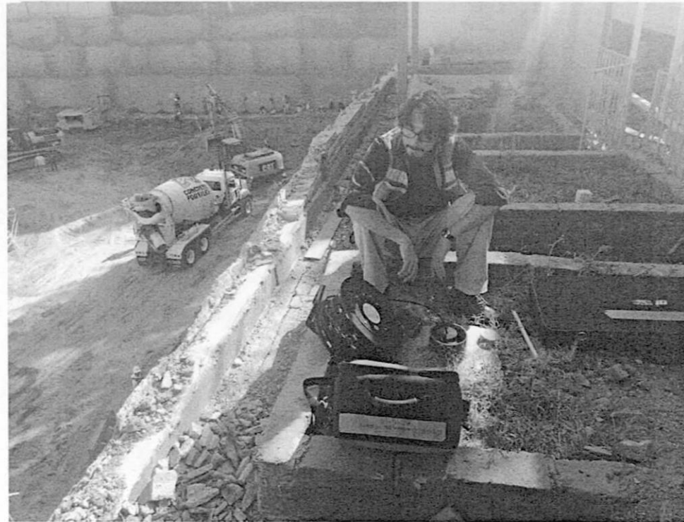
Foto 2. Trabajos de medición en inclinómetro 1.
