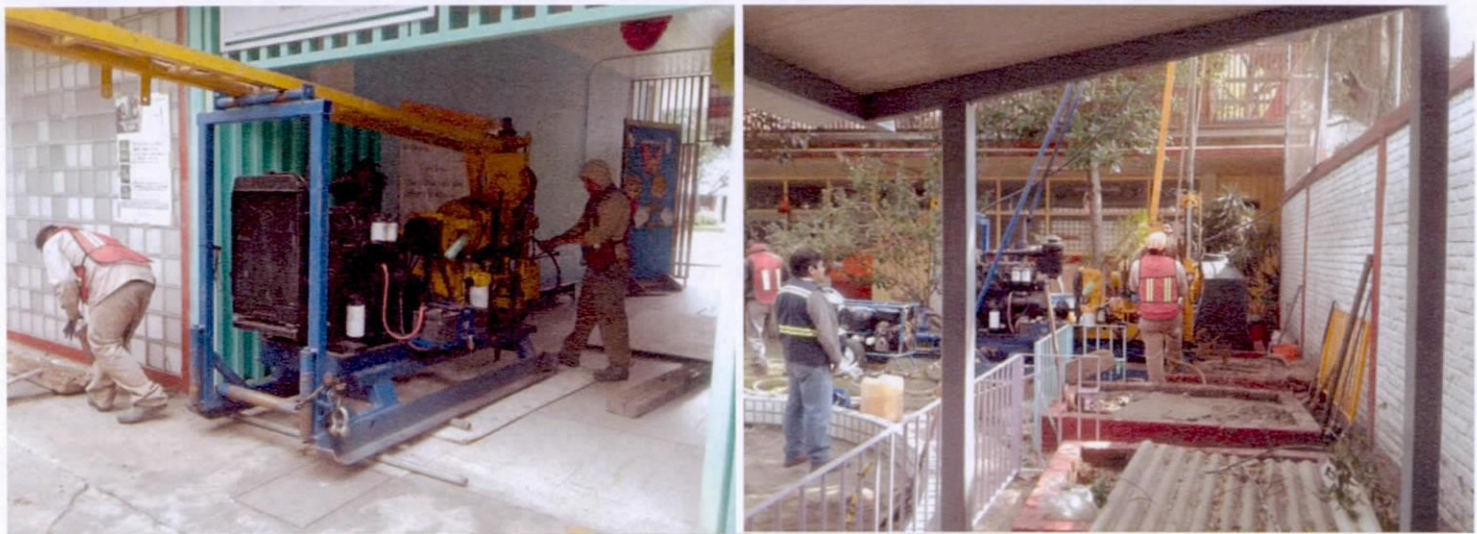
Foto 1 y 2. Maniobras de entrada e inicio de la perforación para INC-1. ✓
