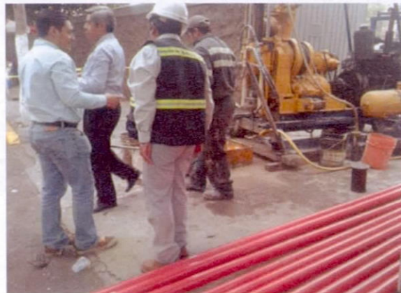
Suministro de tubería tipo ABS para inclinómetros ✓
