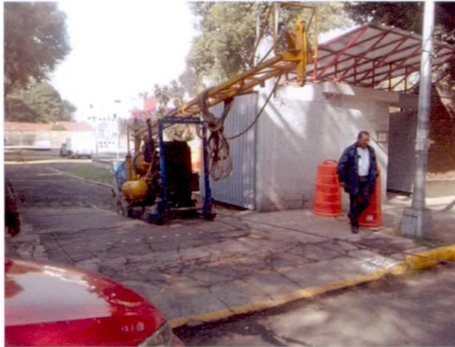
Foto 5 y 6. Maniobras de entrada e inicio de la perforación para INC-3 ✓
