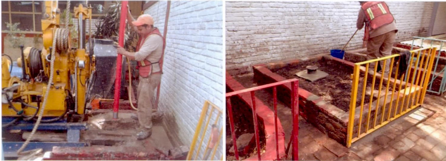
Instalación de INC-1
