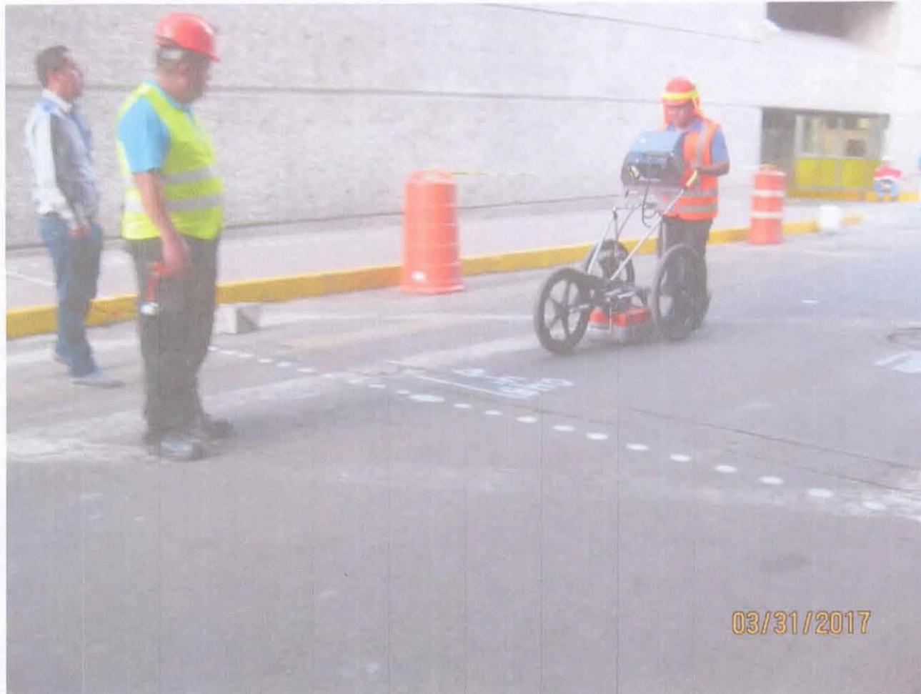
LEVANTAMIENTO DE CALA VIRTUAL CON UNA PROFUNDIDAD DE 7 MTS. CON EQUIPO ELECTRÓNICO GEORADAR EN ÁREA DEL TÚNEL CON UNA LONGITUD DE 20.60 MTS. EN LA CALLE GUSTAVO E. CAMPA.
