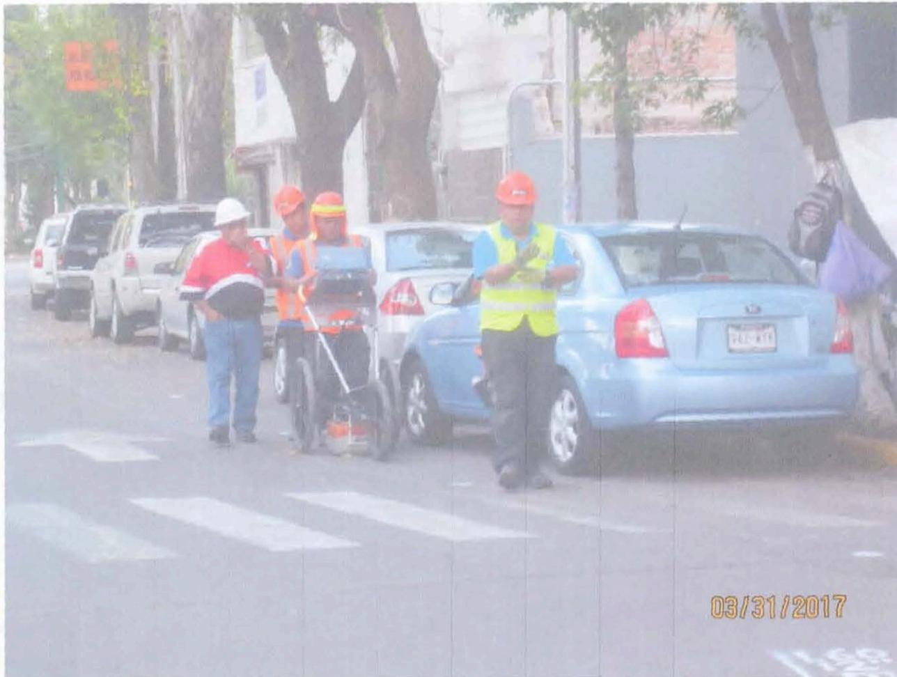
INICIO DE LEVANTAMIENTO DE LÍNEA LONGITUDINAL, CALA VIRTUAL CON UNA PROFUNDIDAD DE 7 MTS. CON EQUIPO ELECTRÓNICO GEORADAR EN CALLE MANUEL EM. PONCE.
