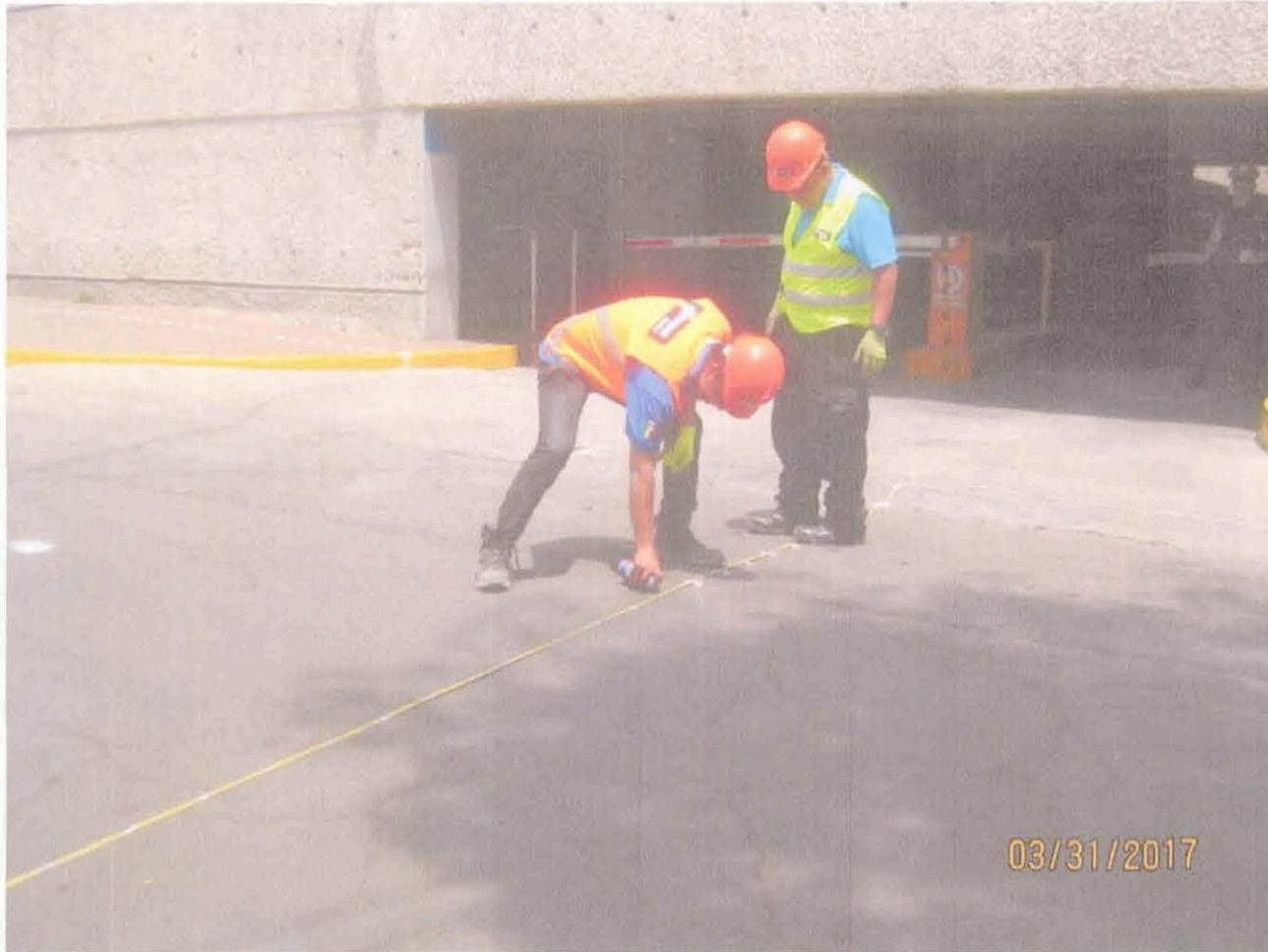
TRAZO DE EJE PARA CALA EN ÁREA DE TÚNEL CON UN UN ANCHO DE 13.60 Y UNA CUADRICULA DE 20 CM EN AMBOS SENTIDOS, POR PERSONAL DE GEORADAR MEXICO.
