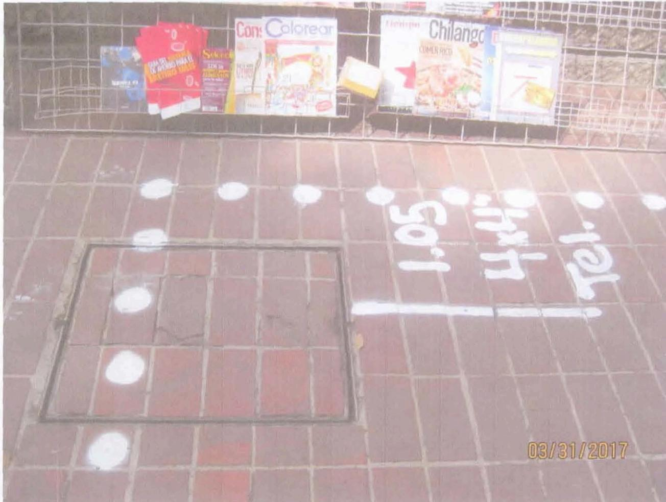
LEVANTAMIENTO FÍSICO DE INSTALACIONES, REGISTRO TELEFÓNICO CON UNA PROFUNDIDAD AL LOMO DE TUBO DE 1.05 MTS, 4 TUBOS DE 4" DE DIÁMETRO, POR PERSONAL DE GEORADAR MÉXICO.
