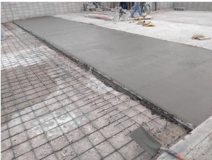
COLOCACIÓN DE PISO LAVADO EN ÁREA DE ESTACIONAMIENTO
