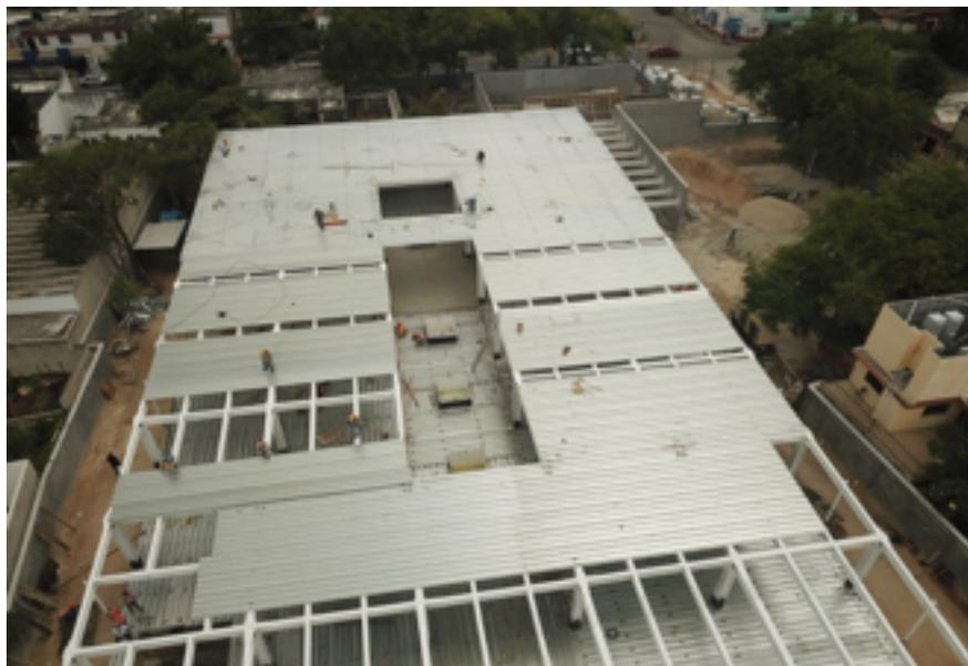
COLOCACIÓN Y FIJACIÓN DE LA LOSACERO EN LA AZOTEA DE LA DELEGACIÓN.
