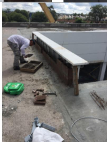
PRETIL, SUMINISTRO Y COLOCACIÓN DE BLOCK JUNTEADO CON MORTERO PARA PRETIL.
