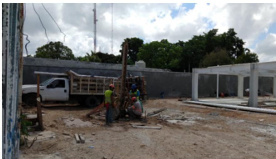
PERFORACIÓN DE POZOS DE ABSORCIÓN PARA EL SISTEMA DE DRENAJE PLUVIAL.
