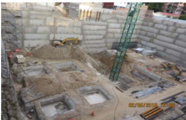
Del 02 de octubre de 2017 al 31 de mayo de 2018 se realizaron los trabajos de excavación a cielo abierto y estabilización de taludes (concreto lanzado, perforación, inyección, colocación de ancla y tensado de ancla).
