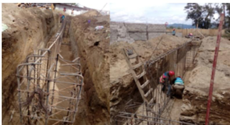
EXCAVACIÓN, HABILITADO DE ACERO, PARA CIMENTACIÓN DE CESI.
