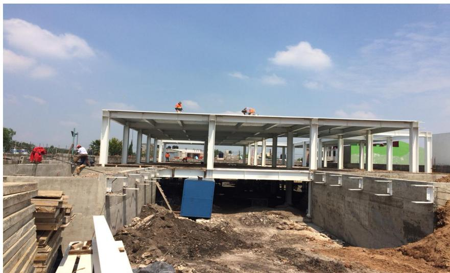
SE TERMINA LA CONSTRUCCIÓN DE LOS DOS MUROS DE CONTENCIÓN PARA EL ACCESO VEHICULAR Y QUE SOSTENDRÁN LA PLAZA DE ACCESO AL CESI.
