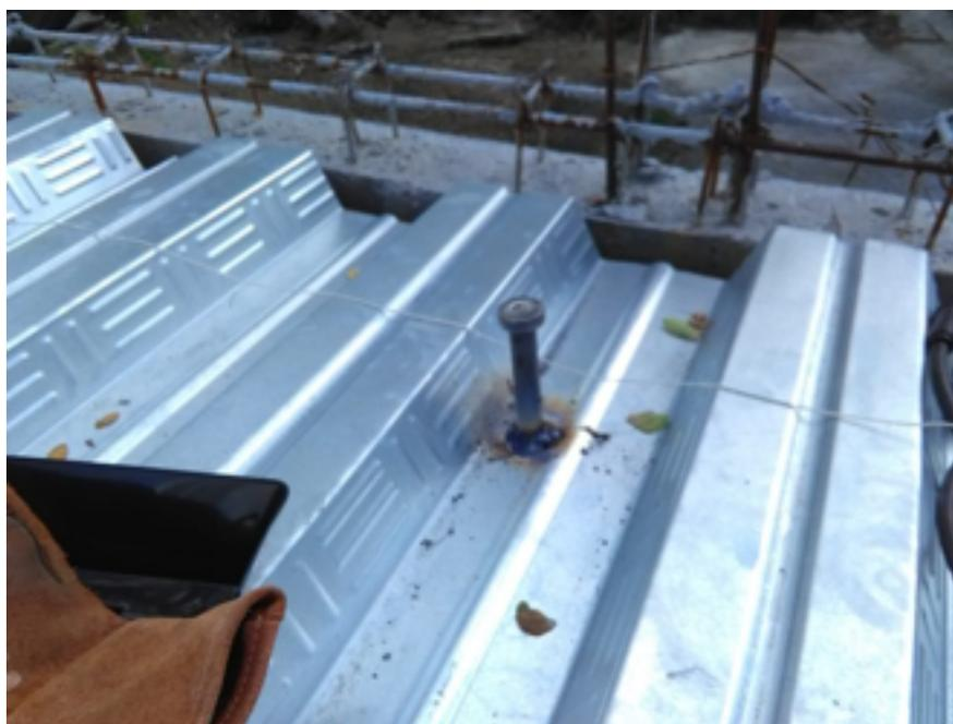
COLOCACIÓN DE PERNOS DE SUJECIÓN PARA LOSACERO EN ENTRE EJES 1A -D; FALTANDO DEL EJE 2A- D, 3 A-D, 4 A-D.
