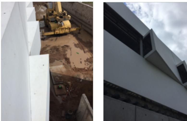
FACHADA EN DELEGACIÓN SELLADO Y COLOCACIÓN DE MURO PREFABRICADO (DUREZZA) EN LA FACHADA PONIENTE, ORIENTE Y NORTE DE LA DELEGACIÓN.
