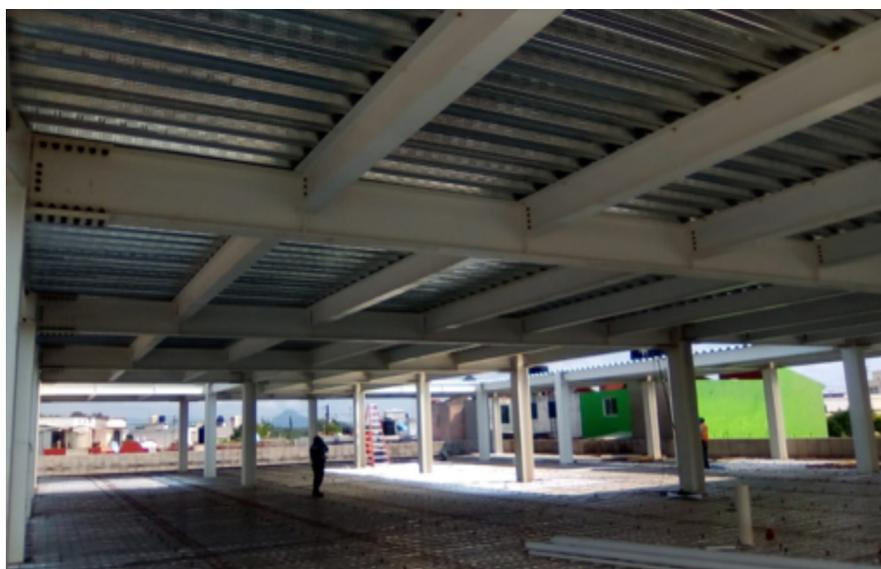
SE TRABAJA EN LA COLOCACIÓN DE LA LOSACERO PARA LA LOSA DEL CESI.
