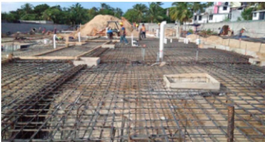
CIMENTACIÓN, SUMINISTRO Y COLOCACIÓN DE ACERO DE REFUERZO EN LOSA DE CIMENTACIÓN. (ÁREA DE LA DELEGACIÓN)
