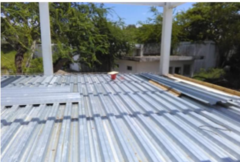
COLOCACIÓN DE LÁMINA LOSACERO EN ENTRE EJES 1A -D; FALTANDO DEL EJE 2A- D, 3 A-D, 4 A-D.
