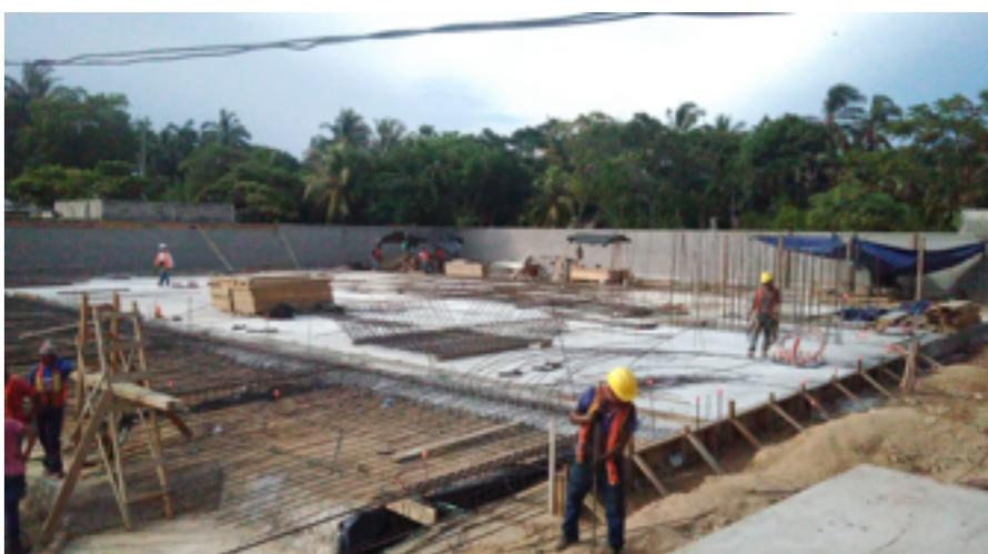
SUMINISTRO Y COLOCACIÓN DE CONCRETO HIDRÁULICO EN LOSA DE CIMENTACIÓN. (ÁREA DE LA DELEGACIÓN)
