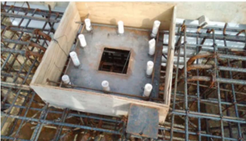
ESTRUCTURA SUMINISTRO Y COLOCACIÓN DE ANCLAS Y PLACAS BASE, PARA SOPORTAR COLUMNAS METÁLICAS, EN DELEGACIÓN.
